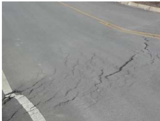
Figura 24: Desplazamiento.
