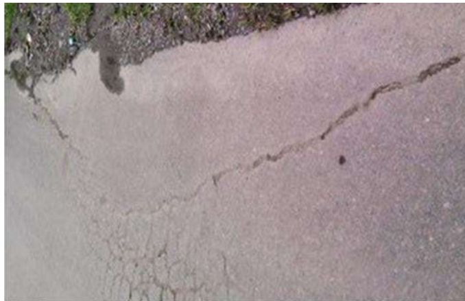
Figura 25: Fisura parabólica.
