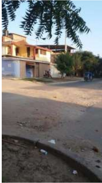
Figura 17: Desnivel carril – berma.
