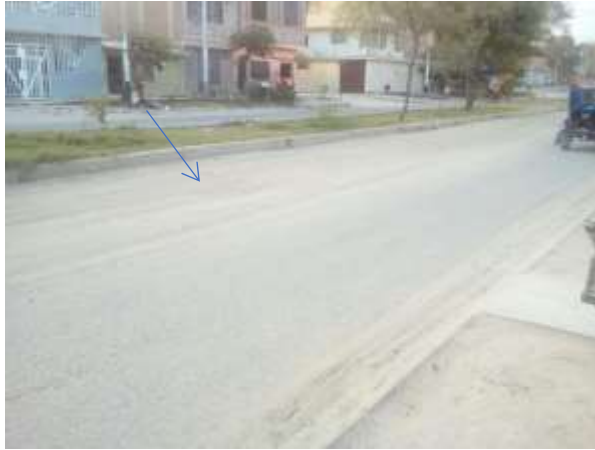
Figura 12: Abultamientos y hundimientos.
