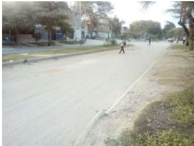
Fuente: Elaboración propia (2017) Intersección Av. Marcavelica y Ca. Sullana.
