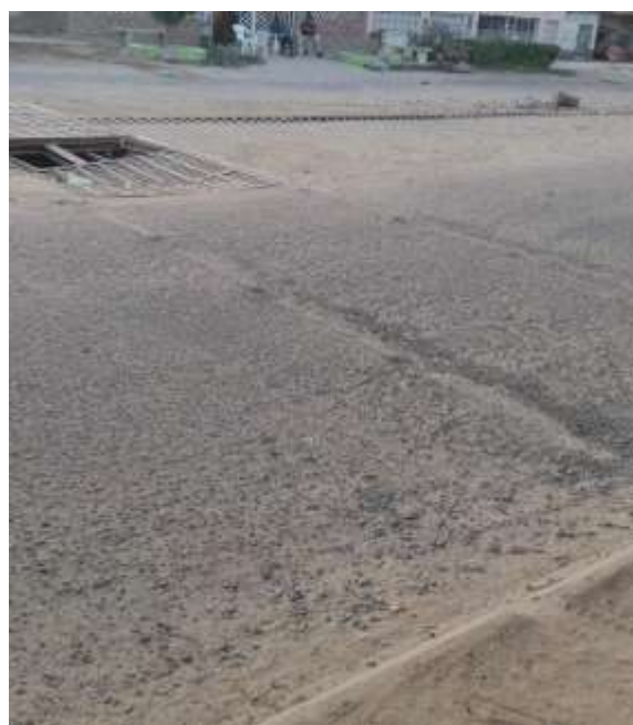
Intersección Av. Marcavelica y Ca. Ayabaca Fuente: Elaboración propia (2017)
