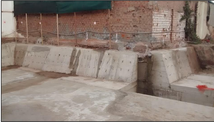
Imagen 03: Excavación de calzada – C.R. Costanera I – Edificio II.
