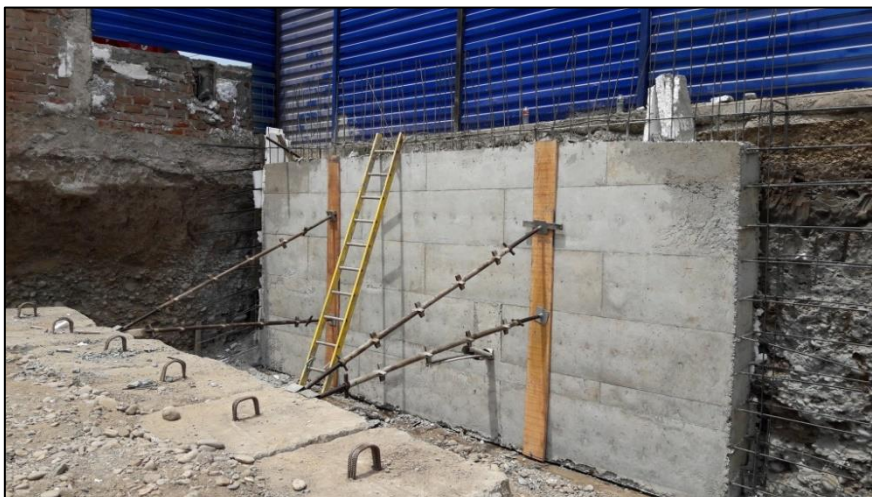
Imagen 06: Muro apuntalado – Universidad Tecnológica del Perú – Sede Lima Norte.
