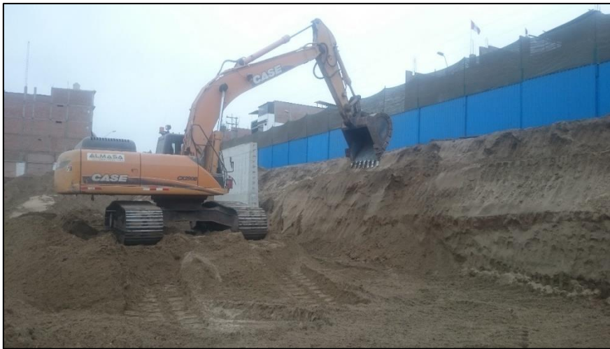
Imagen 01: Sostenimiento de taludes – C.C. Mega Plaza VES II.
