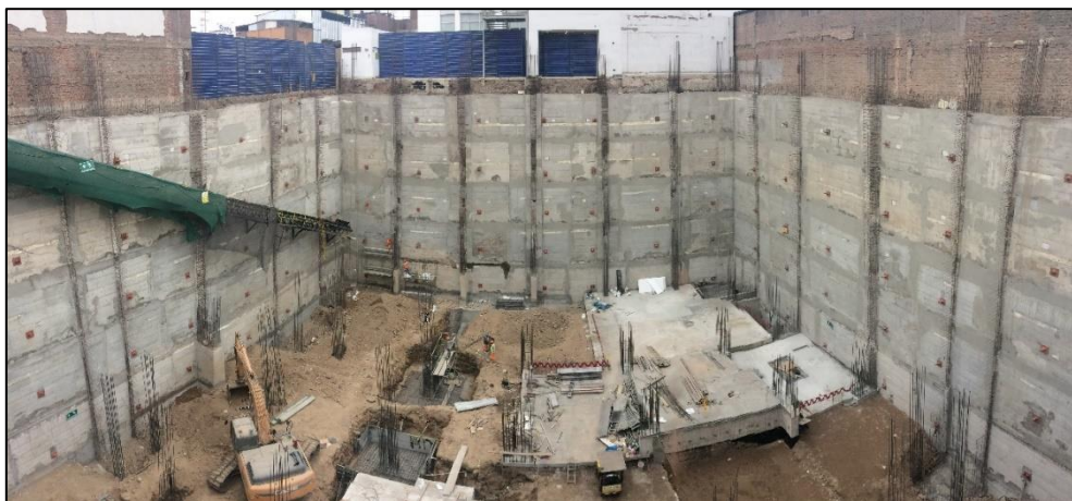
Imagen 12: Muros anclados del proyecto evaluados.
