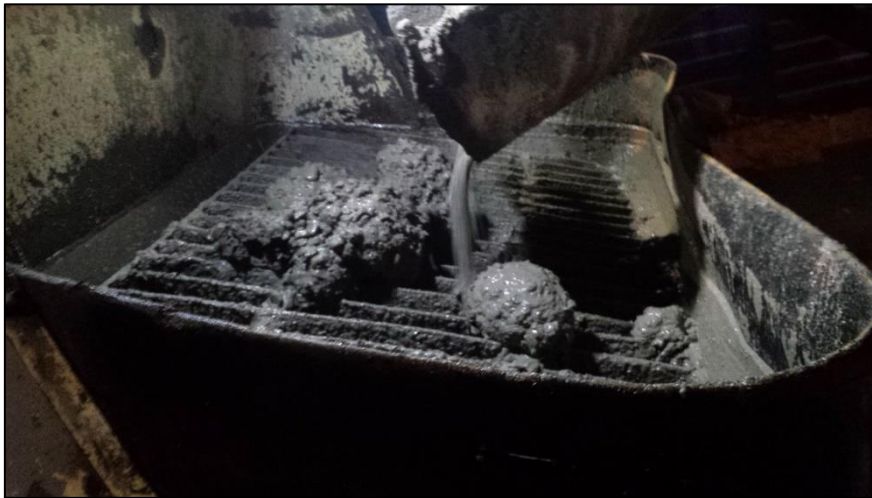
Imagen 19: Concreto con bajo Slump.
