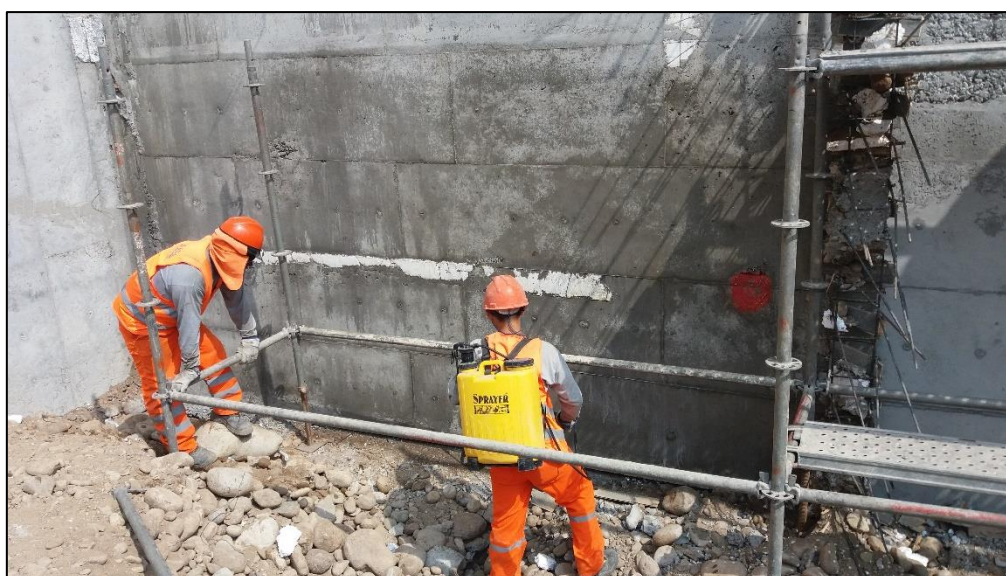
Imagen 27: Proceso de curado del concreto – Muestra 02.
