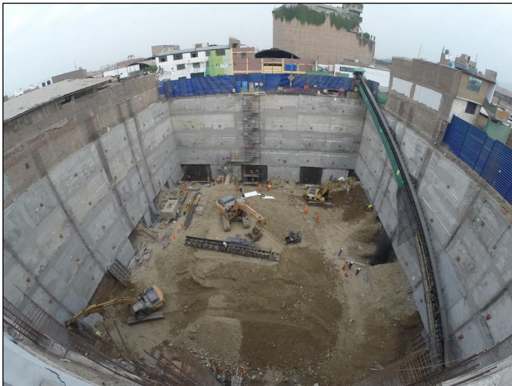
Imagen 09: Avance de los muros anclados – UTP Sede Lima norte.
