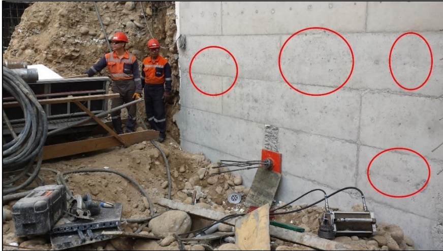
Imagen 20: Burbujas o ampollas halladas después del desencofrado del muro.
