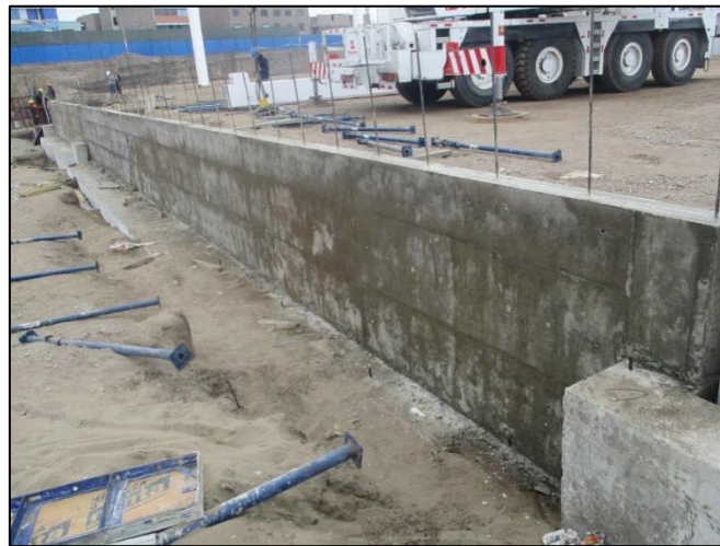
Imagen 05: Muro en voladizo o ménsula – C.C. Mega Plaza VES II.
