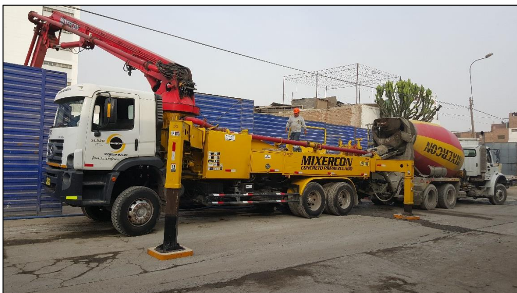
Imagen 24: Transporte y colocación del concreto.
