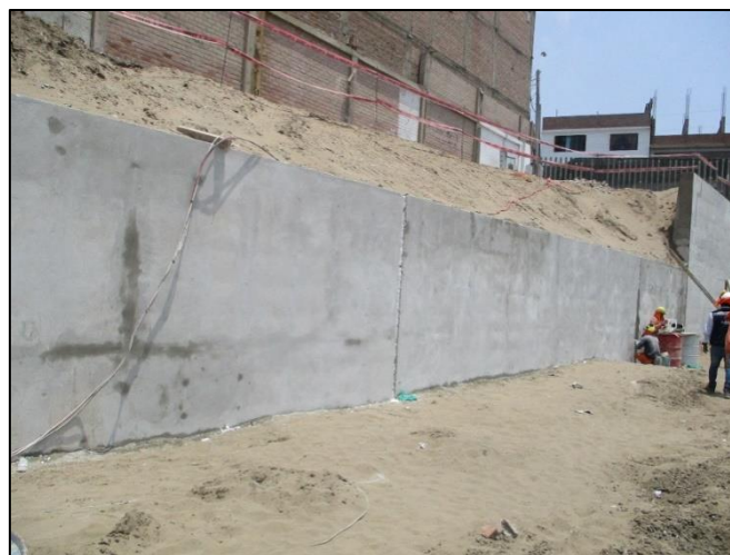
Imagen 04: Muro de contención – C.C. Mega Plaza VES II.
