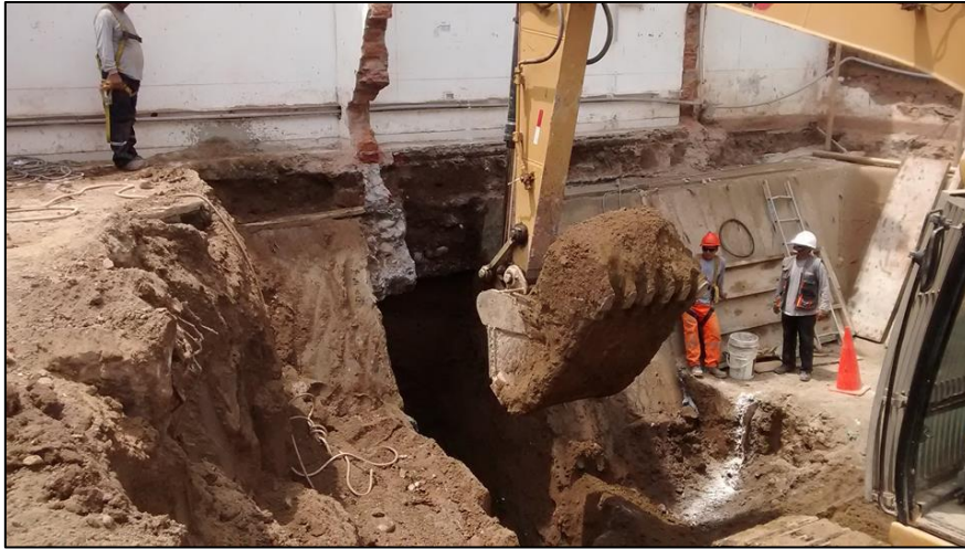
Imagen 02: Excavación de calzadura – C.R. Costanera I – Edificio II.
