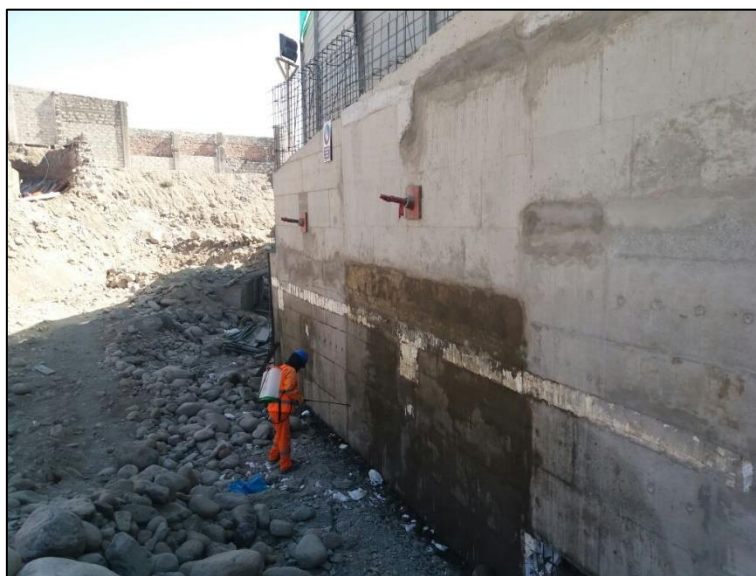
Imagen 26: Proceso de curado del concreto – Muestra 01.
