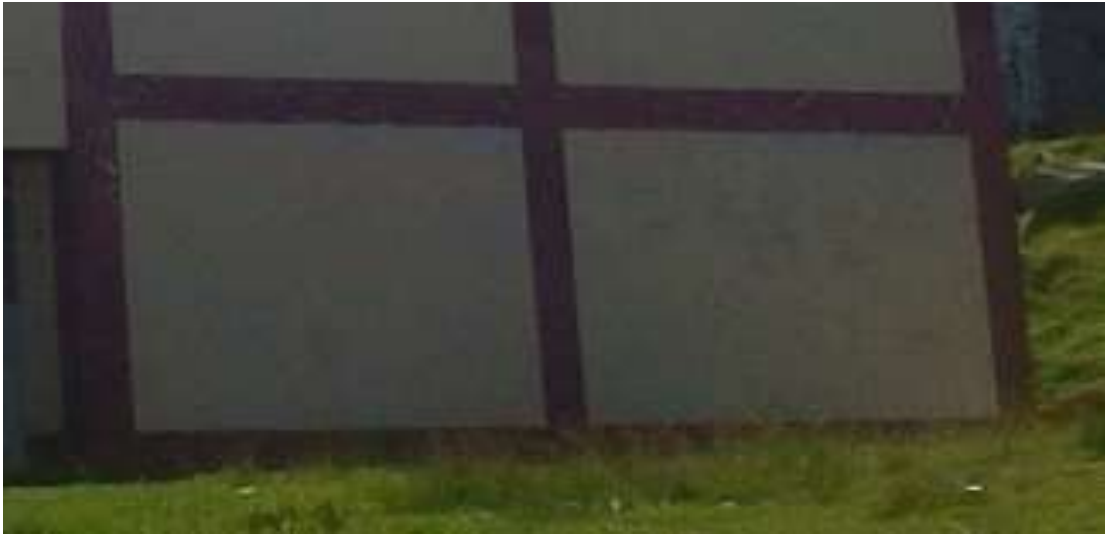
Fotografía 05- Vista panorámica del Tramo Lateral derecha externo del Instituto de Educación Superior Tecnológico Vicente Ferrer – Tumpa
