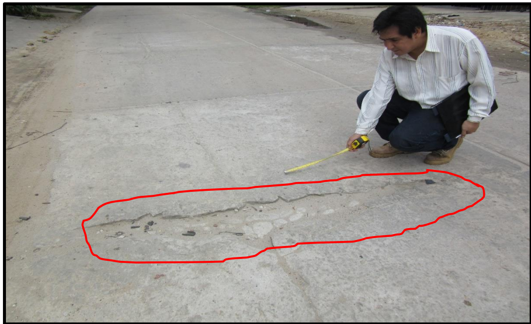
Figura 118: En la vista se observa Fisuras de Losa dividida de Media Severidad en el Jirón Trujillo 12va. Cuadra
