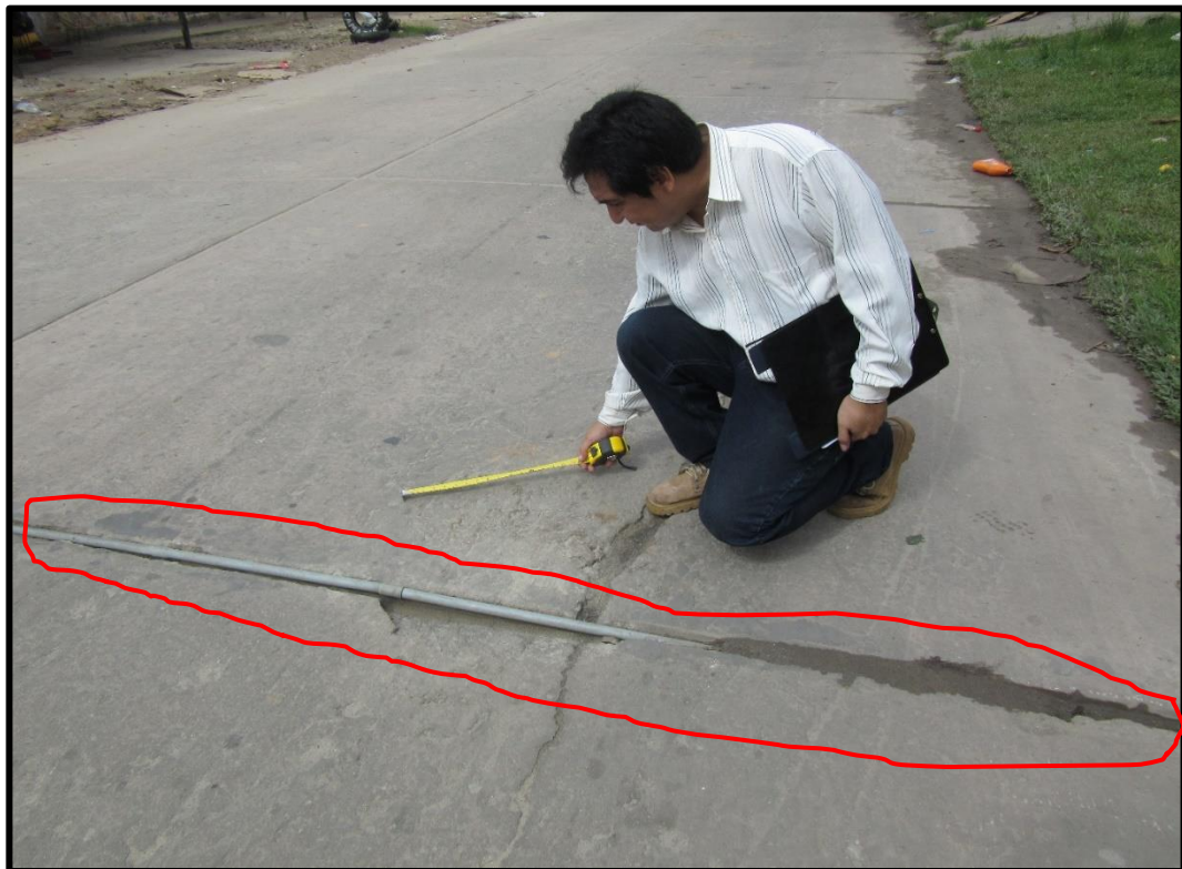
Figura 120: En la vista se observa Fisuras y Grietas de Esquina de Alta Severidad en el Jirón Trujillo 12va. Cuadra
