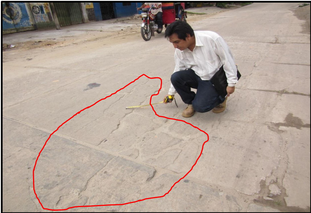
Figura 118: En la vista se observa Fisuras de Losa dividida de Media Severidad en el Jirón Trujillo 12va. Cuadra
