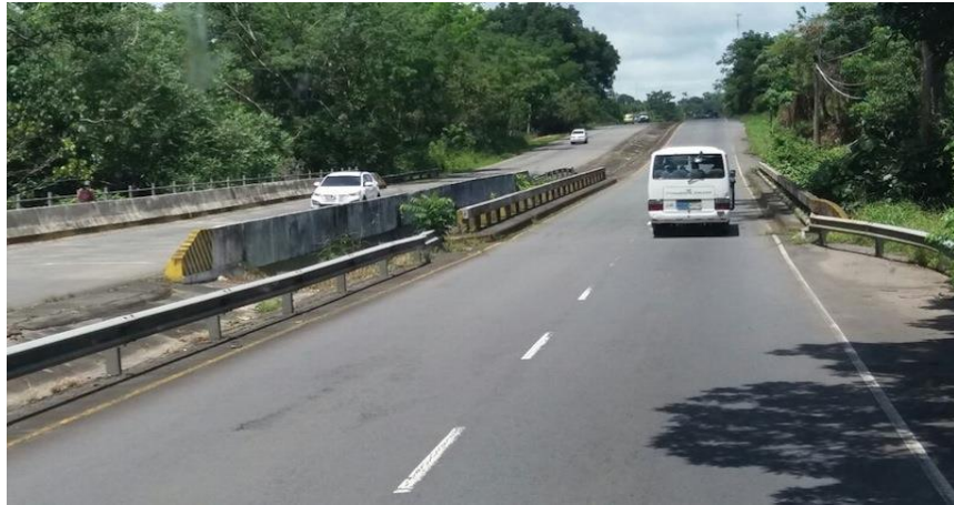
Figura 02: Rehabilitación Carretera CA02W
