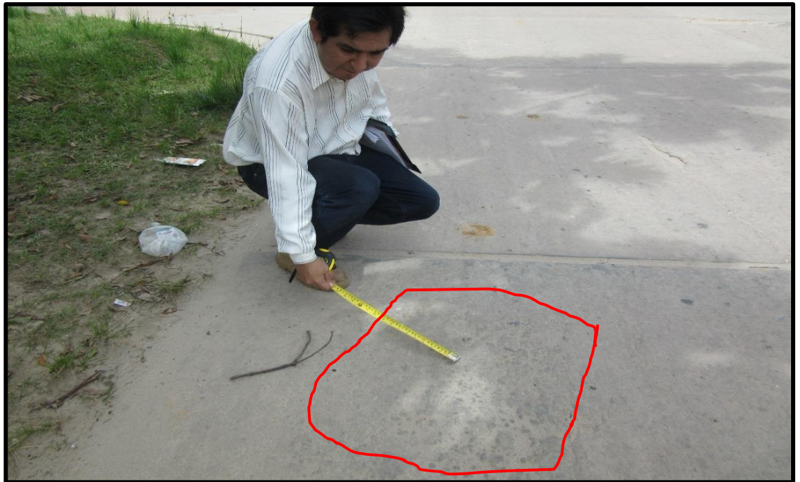
Figura 125: En la vista se observa Fisuras de Grietas Lineal Longitudinal y Transversal de Baja Severidad en el Jirón Trujillo 13va. Cuadra
