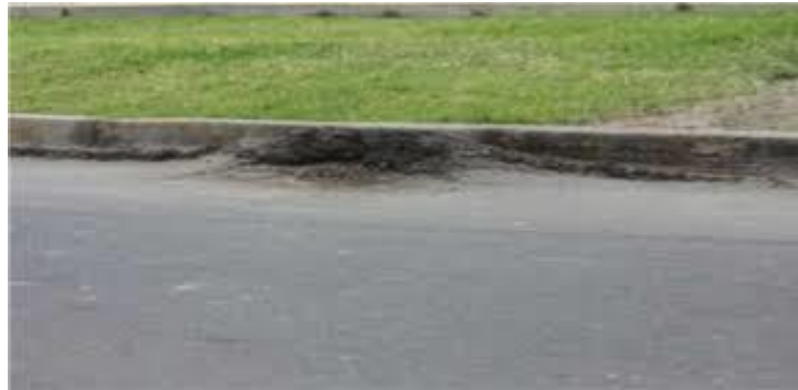
Figura 21: Deformación por Hinchamiento
