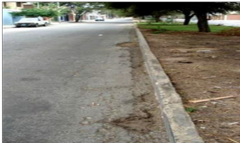
Figura 25: Desintegración en los Bordes de la Calle
