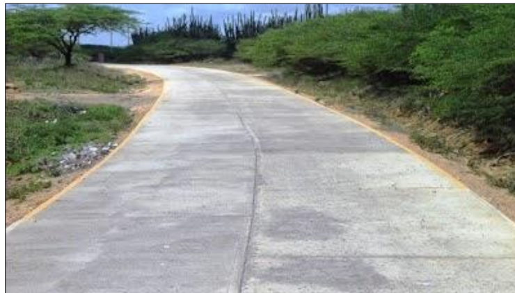
Figura 09: Pista de Carretera de tipo Pavimento Rígido y/o Concreto
