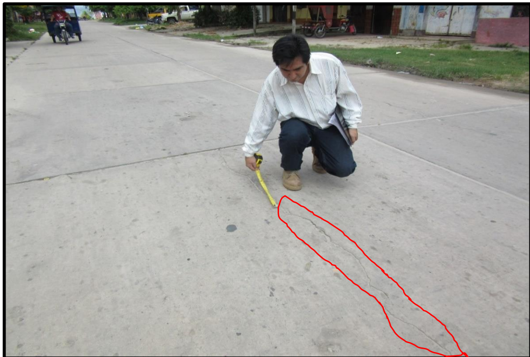
Figura 123: En la vista se observa Fisura de Desnivel de Carril de Severidad Media en el Jirón Trujillo 13va. Cuadra
