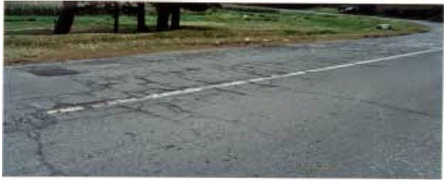
Figura 14: Fisuras en calles de Tipo “Arco”
