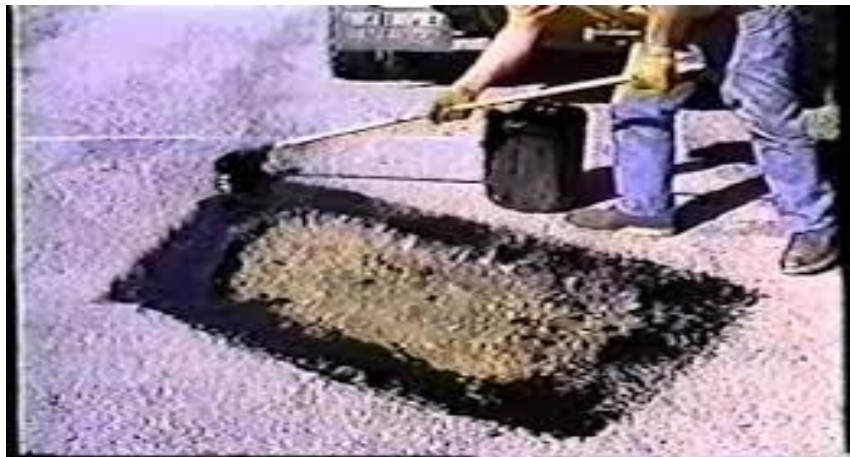
Figura 27: Reparaciones o parchados en el Pavimento
