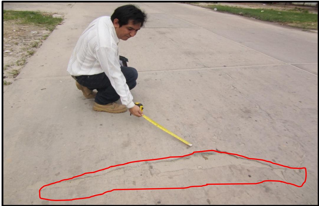
Figura 123: En la vista se observa Fisura de Desnivel de Carril de Severidad Media en el Jirón Trujillo 13va. Cuadra
