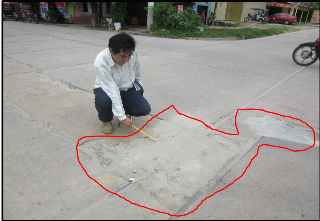
Figura 120: En la vista se observa Fisuras y Grietas de Esquina de Alta Severidad en el Jirón Trujillo 12va. Cuadra
