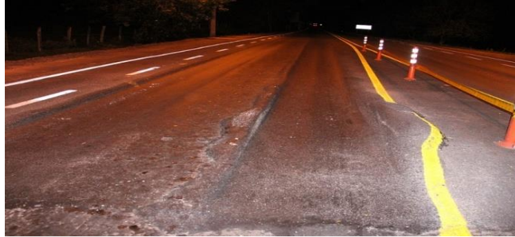
Figura 19: Deformación por efecto de corrimiento
