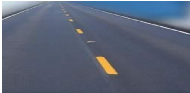
Figura 07: Pista de Carretera de tipo Pavimento Flexible
