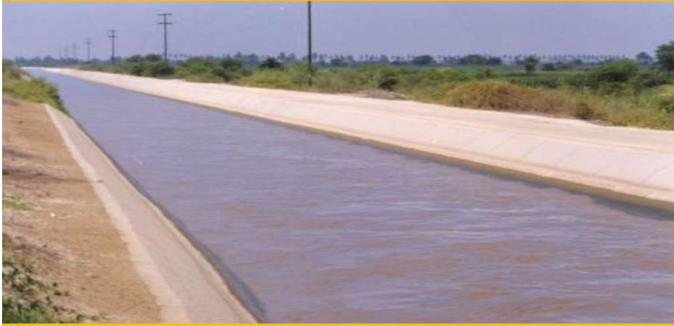
Imagen 8. Sección Trapezoidal
