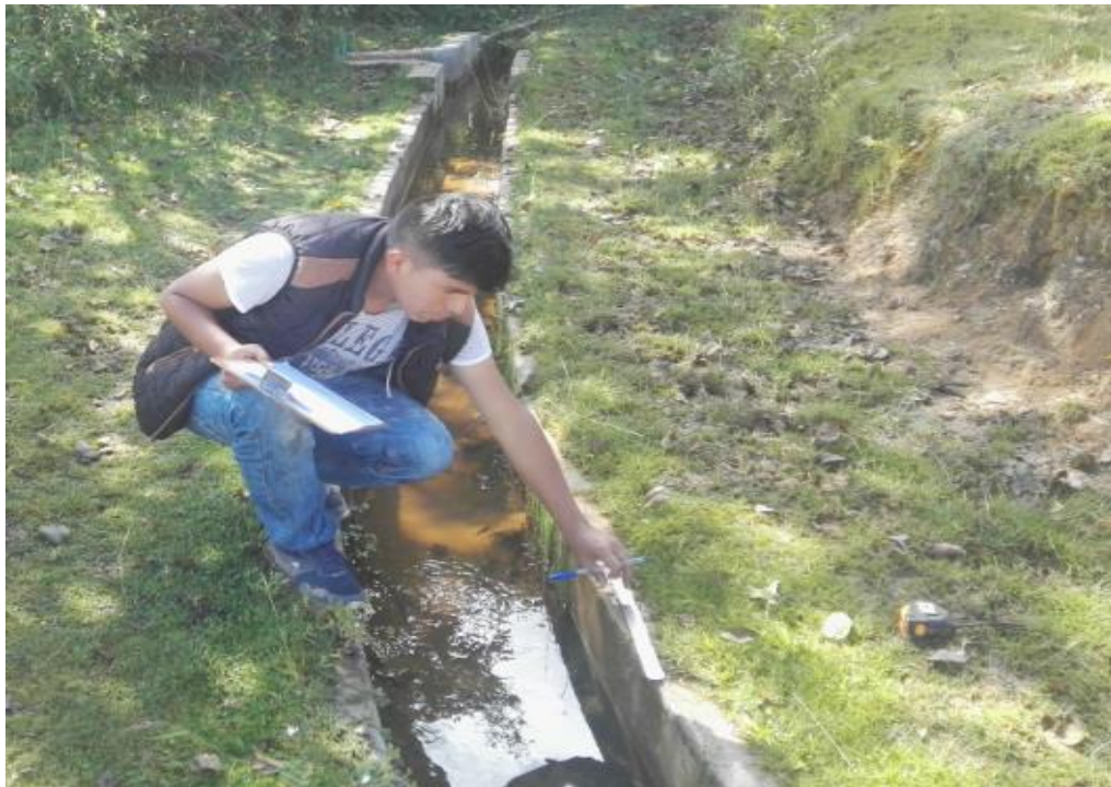
Fotografía 02- vista muro izquierdo midiendo la grita en el canal de irrigación Mesacucho caserío de Chuspin distrito de Casca provincia de Mariscal Luzuriaga.
