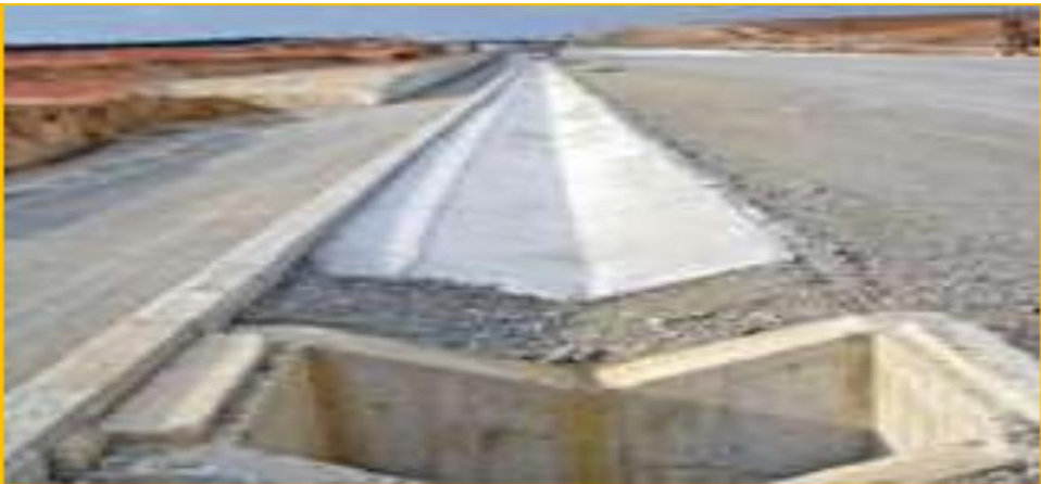
Imagen 7. Sección triangular
