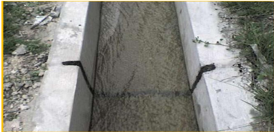
Imagen 6. Sección rectangular
