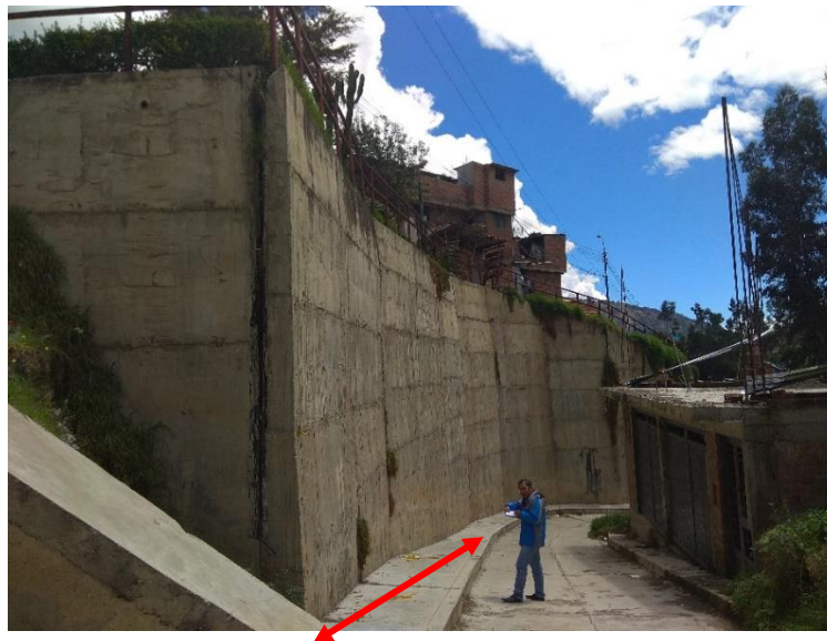
Fotografía 1: Vista general del muro de contención en el Jr. Puquiales.
