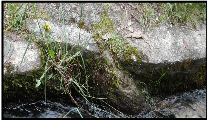
Imagen 19: Fracturamiento en el lateral del canal.
