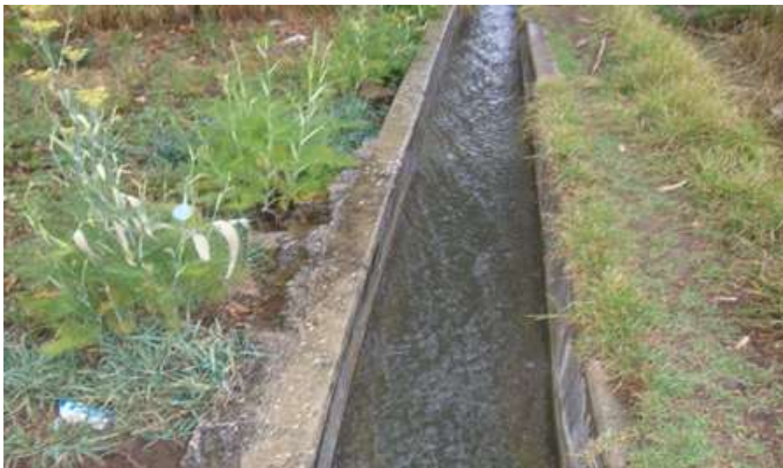
FOTO N° 01: Fotografía del Canal Pomabamba - Huayllan en el punto de inicio.
