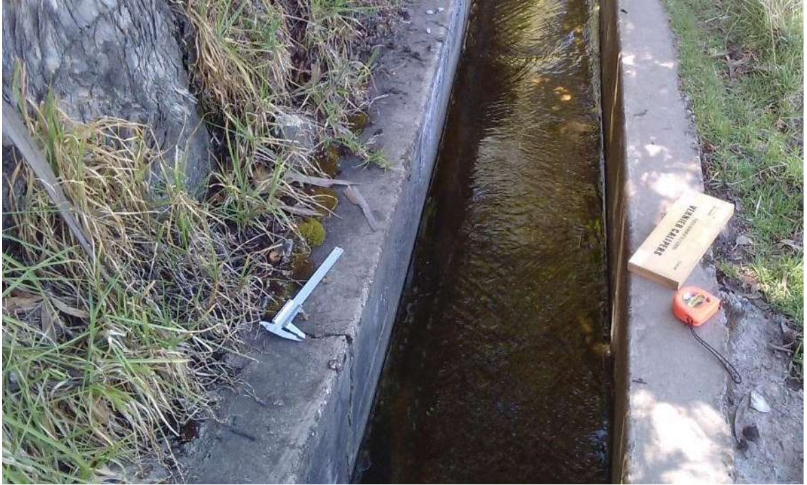
FOTO N° 03: Fotografía del Canal Pomabamba - Huayllan instrumentos de medición utilizados.
