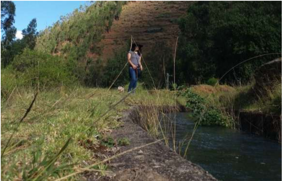
FOTO N° 04: Fotografía del Canal Pomabamba - Huayllan
