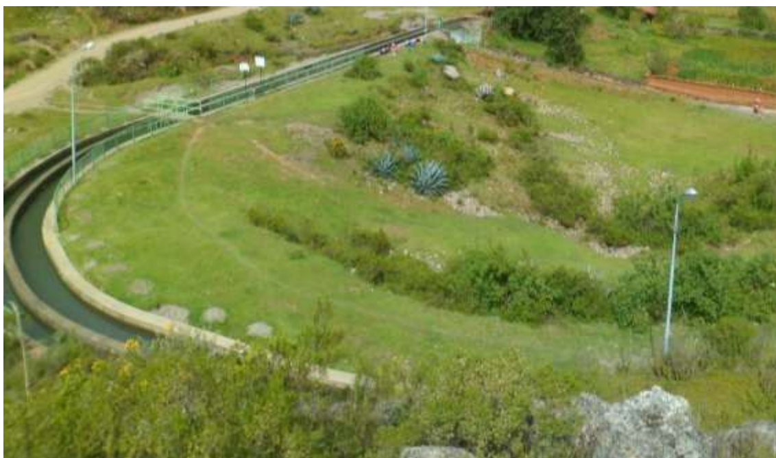
FOTO N° 02: Fotografía del Canal Pomabamba
