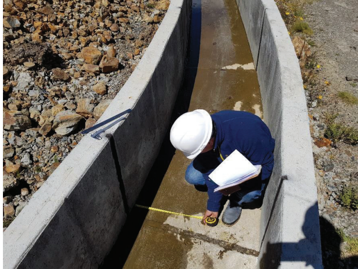
Imagen N° 28: En la vista se observa la medición de la área erosionada en la unidad muestral N° 08
