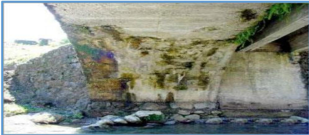
*Figura 36.* Estribos de un puente con presencia de humedad.
