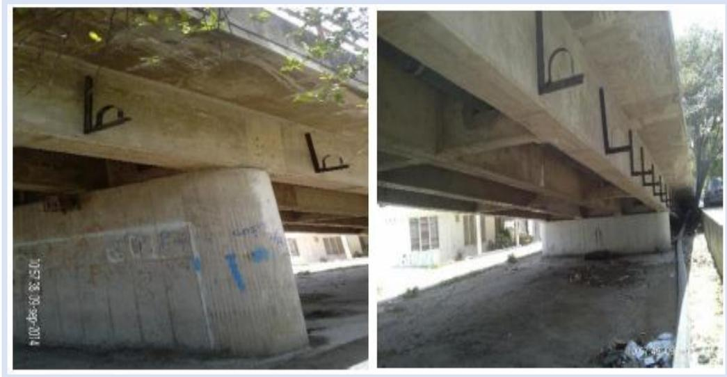
*Figura 7.* A la izquierda, Pila maciza interior. A la derecha, Pila maciza exterior.
