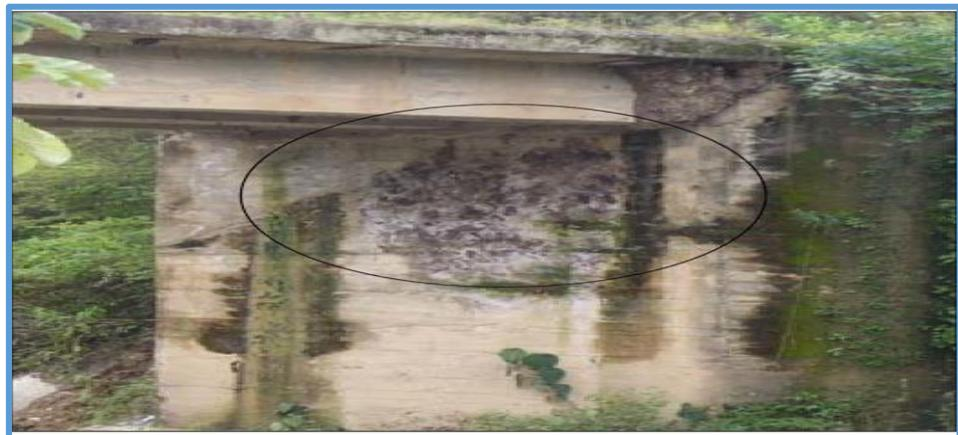
*Figura 50.* Eflorescencia en el concreto del Estribo de un Puente.
