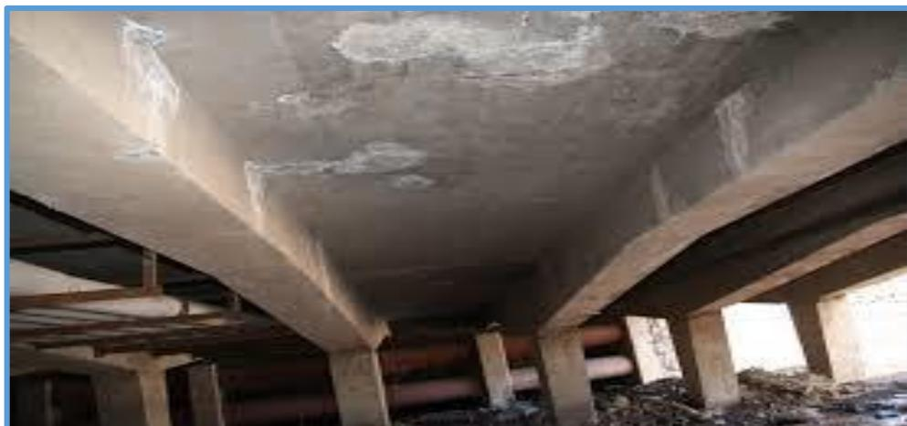
*Figura 42.* Fisuras en la estructura de un Puente
