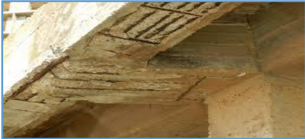
*Figura 51. Corrosión en vigas de un Puente.*
