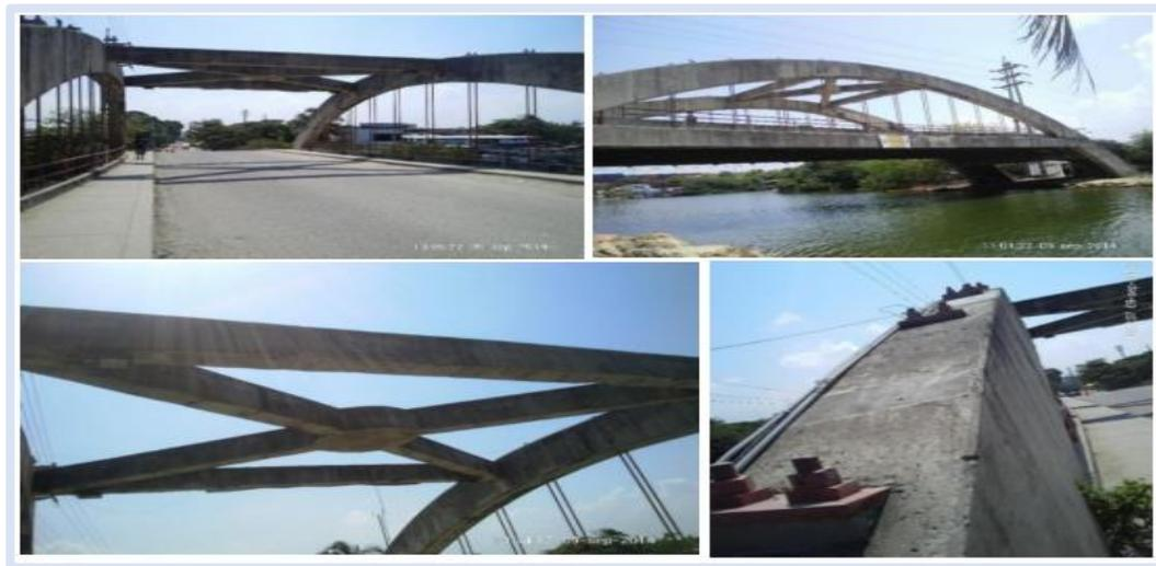
*Figura 8.* Vista, estructura superior y pernos del arco.
