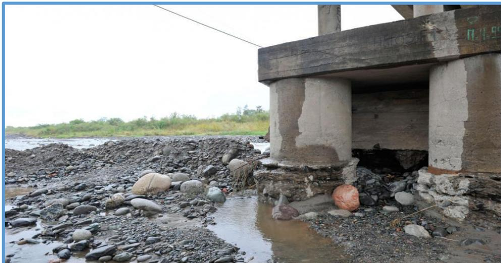
*Figura 39. Erosión de los estribos de un Puente.*
