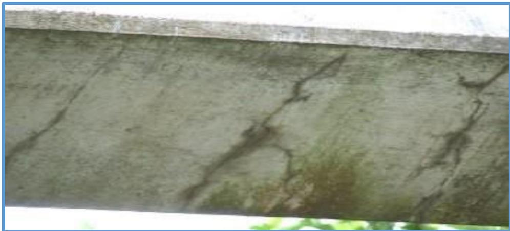
*Figura 44. Grietas en una dirección (debido a flexión en la viga)*
