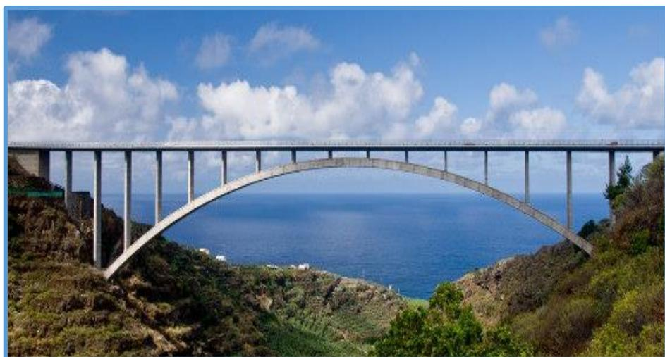
*Figura 30.* Puente en arco de tablero superior.
