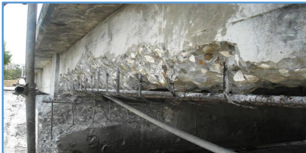
*Figura 38. Desprendimiento del Concreto en la Viga de un Puente.*
