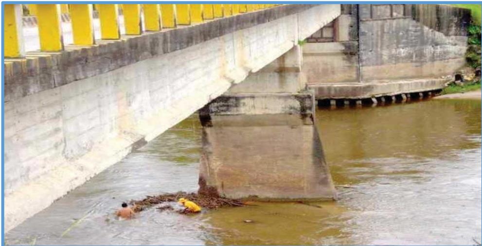
*Figura 40.* Desgaste de los Estribos y Pilares de un Puente
