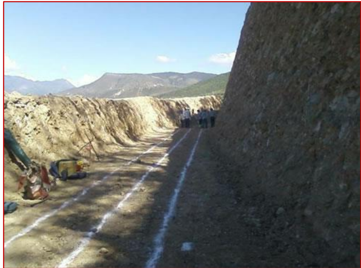
Imagen 5: Trazo y replanteo de un canal de regadío
