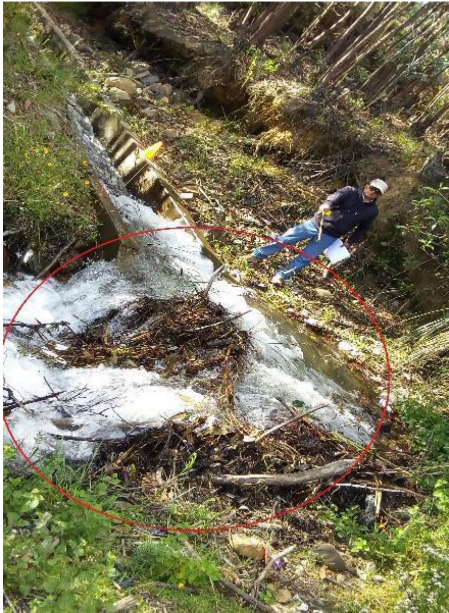
Fotografía 14: Se observa la patología sedimento de la unidad muestral 8.
