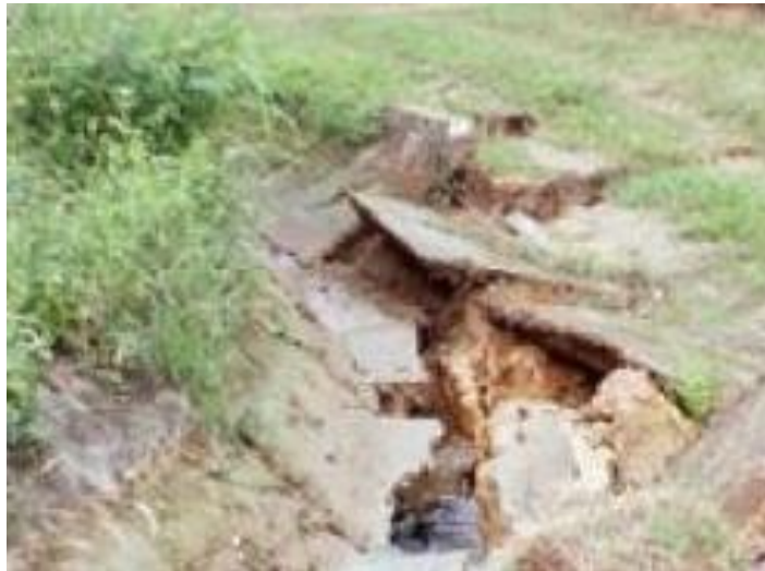
Figura 3. Hundimiento de un canal.
