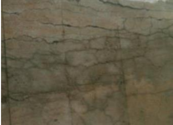
Figura 5. Delaminación.
