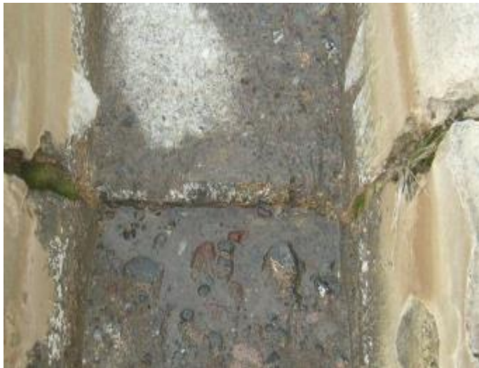
Figura 8. Sello de junta en el canal.
