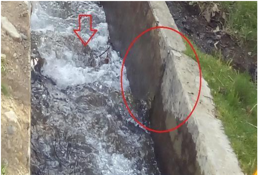
Fotografía 12: Se observa la patología desplazamiento de panel y sedimento de la unidad muestral 6.
