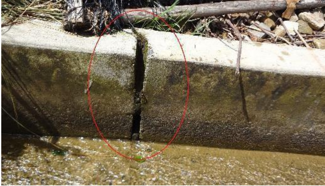
Fotografía 16: Se observa la patología sello de junta, unidad muestral 9
