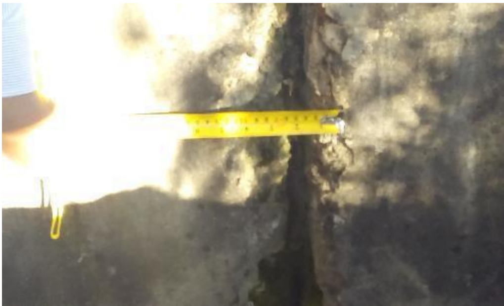
Fotografía 20: Se observa la patología sello de juntas de la unidad muestral 11.
