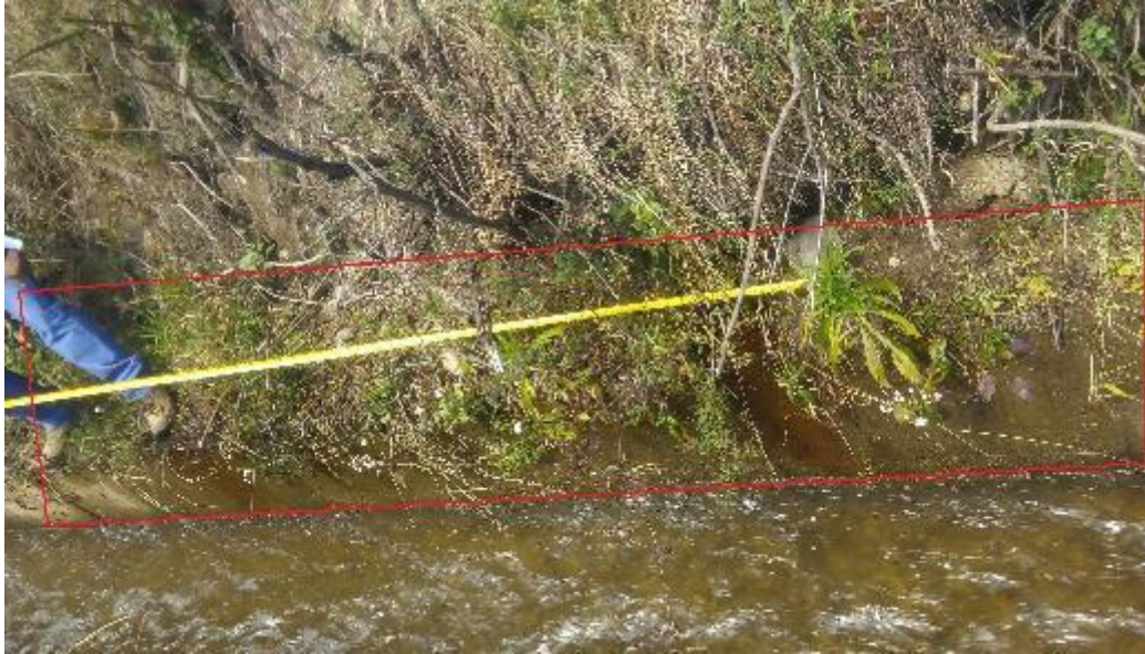
Fotografía 1: Se observa presencia de la patología humedad y vegetación.
