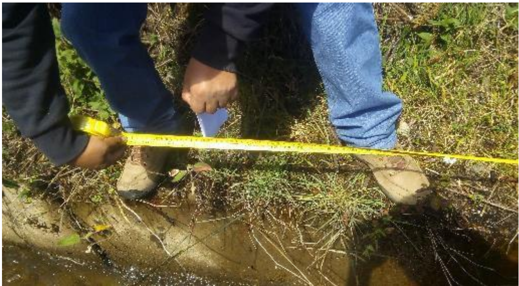
Fotografía 2: Se observa la comprobación de las dimensiones.
