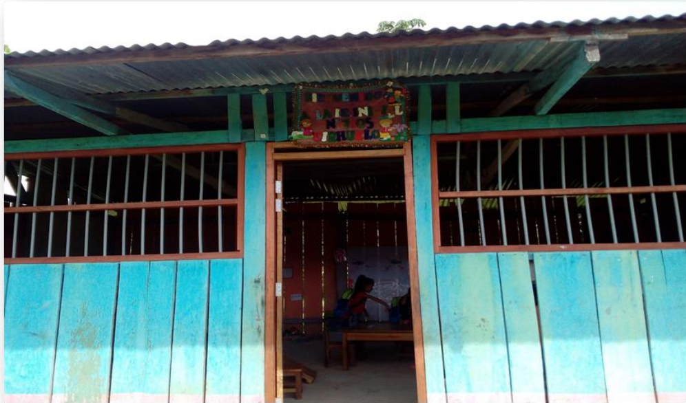
Foto N° 01: Fotografía de la fachada de la I.E. Ciruelo.
