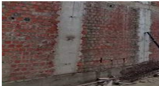
Imagen 2. Columnas de concreto armado
