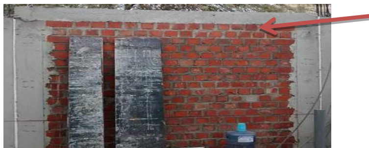
Imagen 3. Viga de concreto armado
