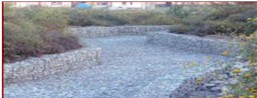
Imagen 6: Revestimiento de canal con gaviones
