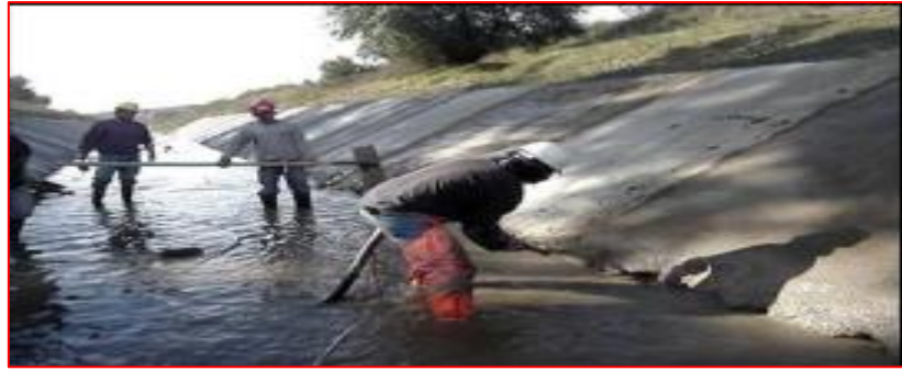
Imagen 5: Revestimiento de canal con mortero
