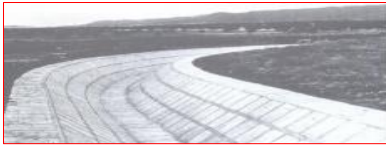
Imagen 3: Revestimiento con mampostería de piedra.
