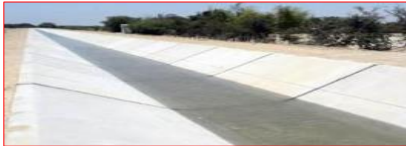
Imagen 4: Revestimiento del canal con concreto
