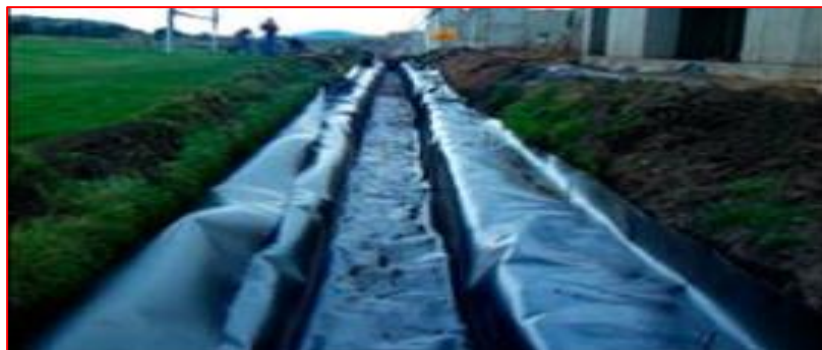
Imagen 7: Revestimiento de canal con geo membrana
