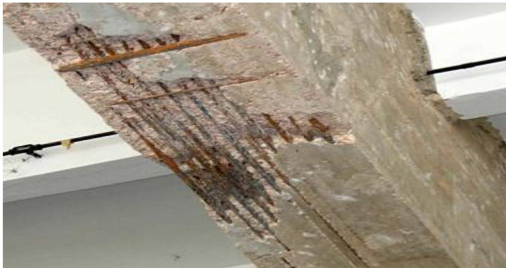
*Figura 18.* Corrosión del Acero de Refuerzo en una columna.
