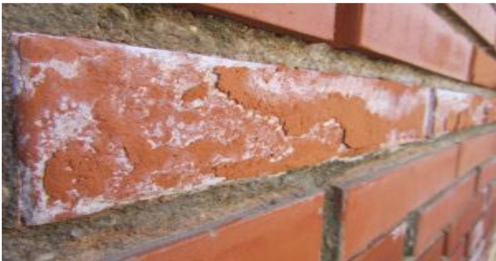
*Figura 20.* Laminación del ladrillo debido a las eflorescencias
