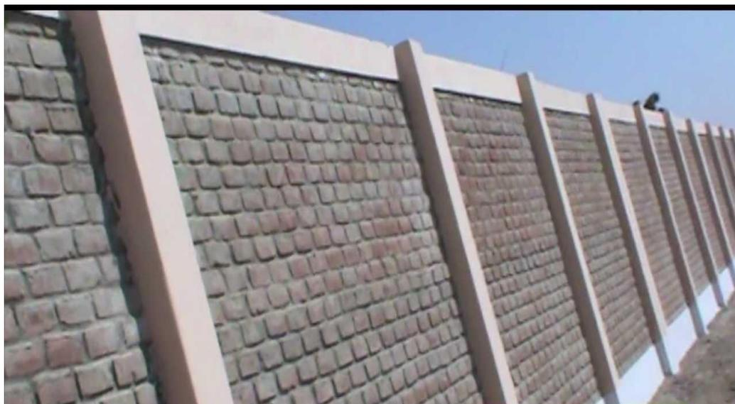
*Figura 03.* Cerco perimétrico de albañilería confinada.
