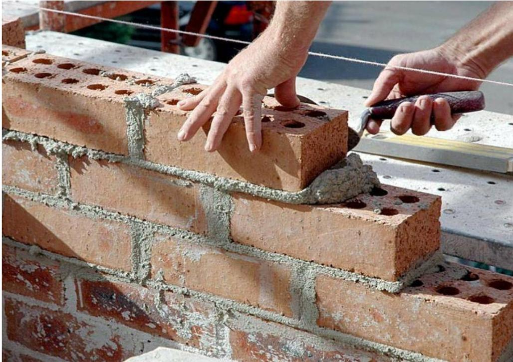
*Figura 13.* Mortero en albañilería.
