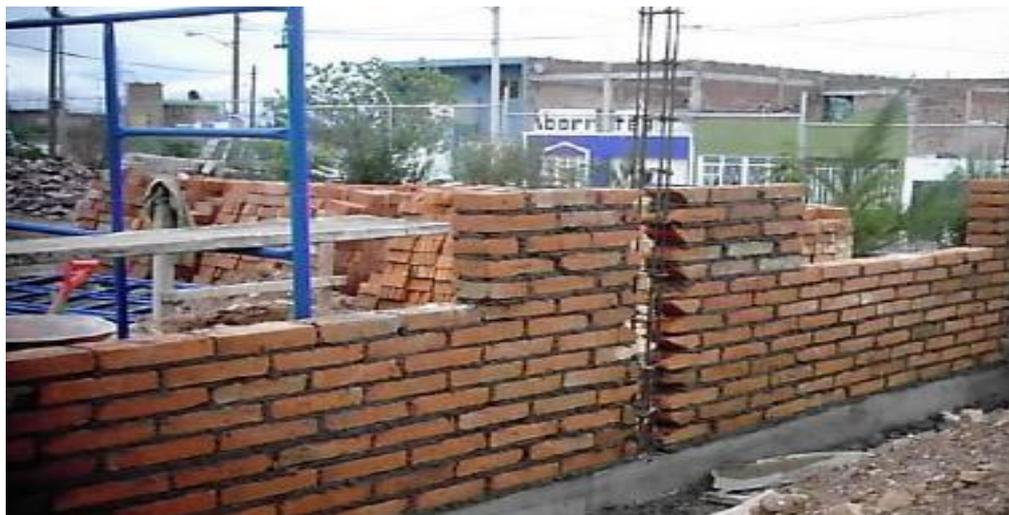
*Figura 10.* Muros tabique o no portante
