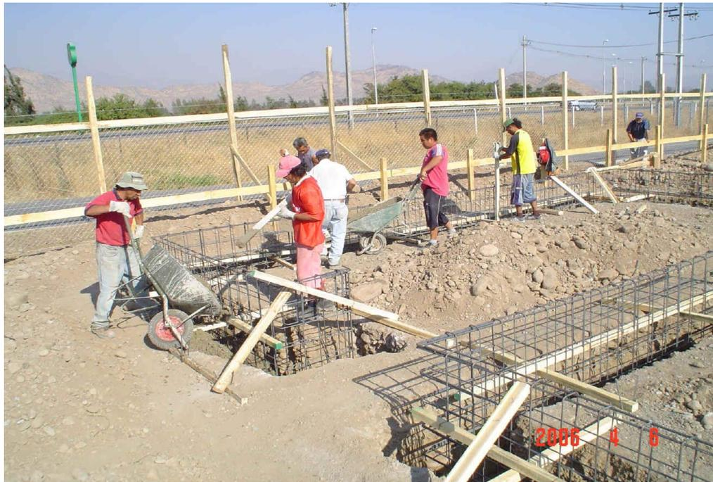
*Figura 14.* Vaciado de concreto para sobrecimiento armado.
