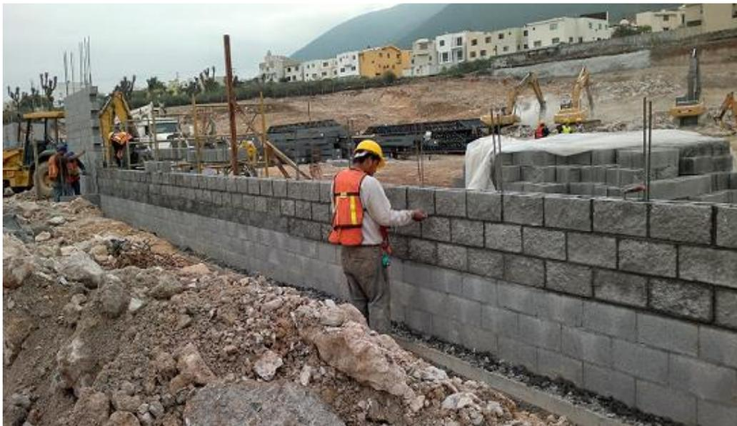
*Figura 05.* Muro de albañilería reforzada o armada
