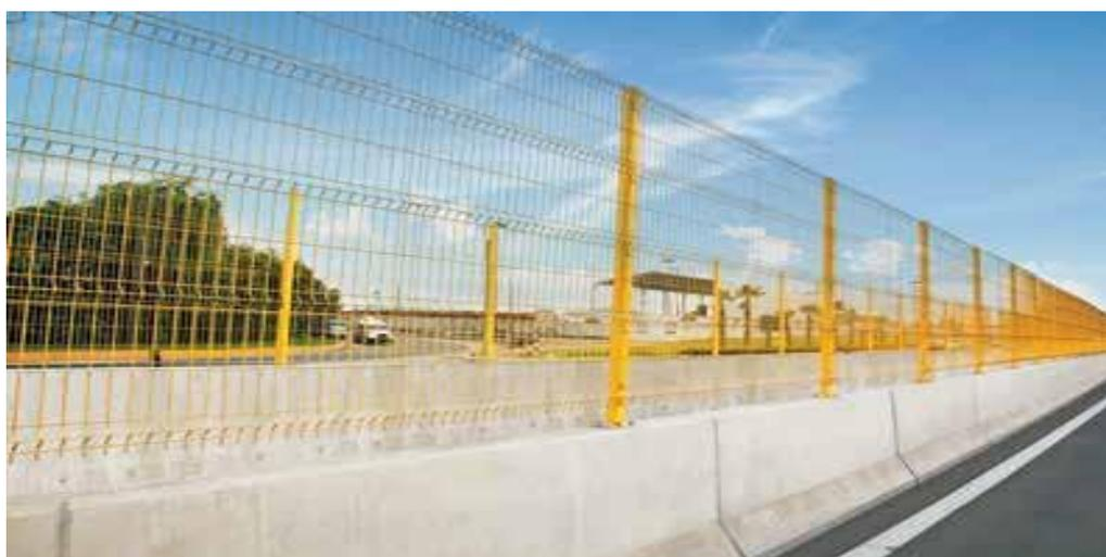
*Figura 02.* Cerco con Alambre galvanizado más pintura electrostática
