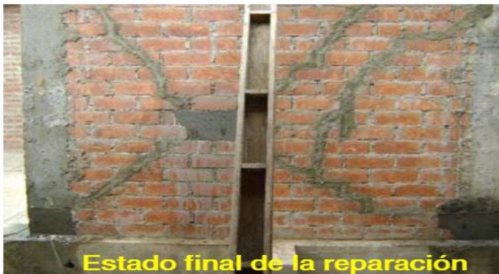
*Figura 23.* Reparación de grietas en muro confinado
