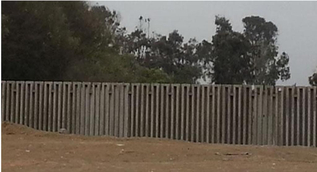
*Figura 03.* Cerco de concreto Tipo UNI.
