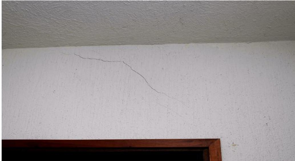
*Figura 21.* Presencia de fisura en un muro de albañilería
