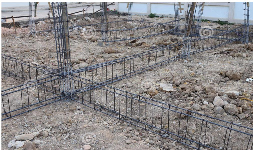
*Figura 15.* Habilitación y colocación del acero de refuerzo.
