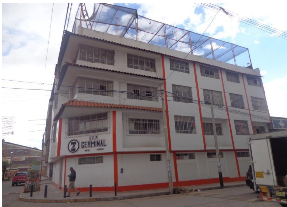
Foto N°1: Fachada de la “I.E.P” Germinal.
