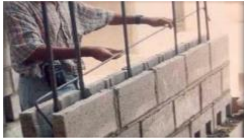
FIGURA 1. Albañilería armada
