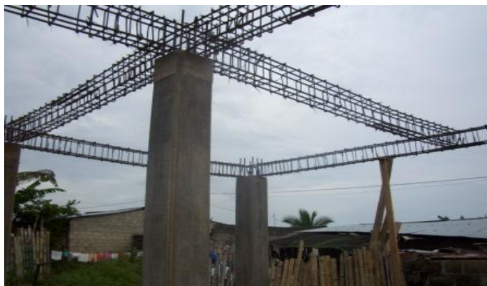
Figura 8. Diseño y Construcción de columnas Nota. Fuente: Revista ARQHYS Diciembre 2012
