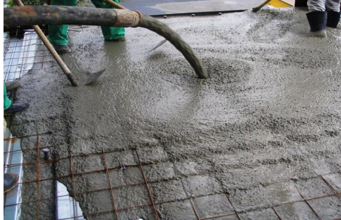
Figura 13. Diseño y Construcción de concreto armado
