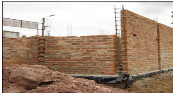
Figura 11. Muro de albañilería.
