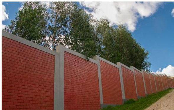
Figura 3. Cerco perimétrico de albañilería confinada
