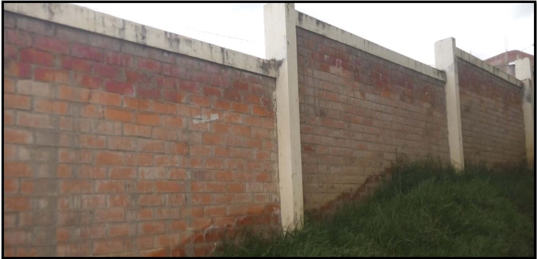
Fotografía 03: Tramo N° 02-08 (Interno) del cerco perimétrico de la Institución Educativa
