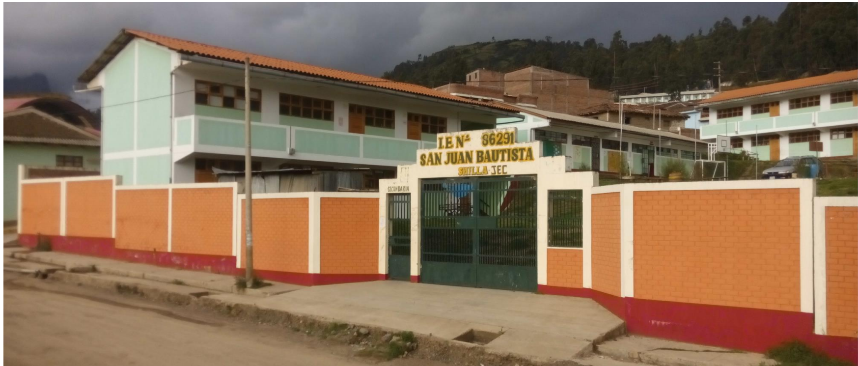
Fotografía 01: Cerco Perimétrico de la Institución Educativa San Juan Bautista.
