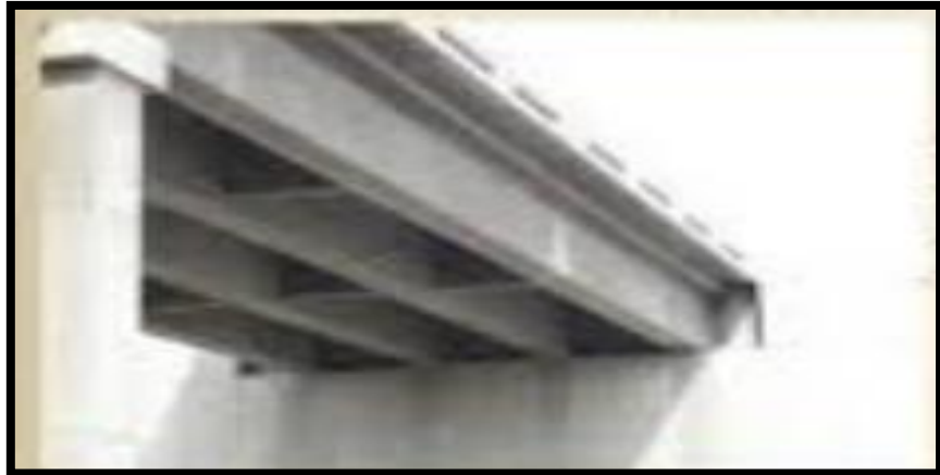
Figura N° 6: Puentes de Viga
