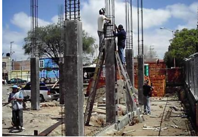
Figura 05. Desencofrado de columnas.
