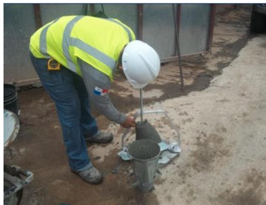
Figura 07. Pruebas realizadas al concreto Nota Fuente: Barzola C. (2015)
