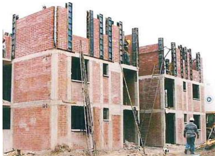
Figura 03. Albañilería confinada en proceso constructivo. Nota Fuente: Ministerio de vivienda (2009)
