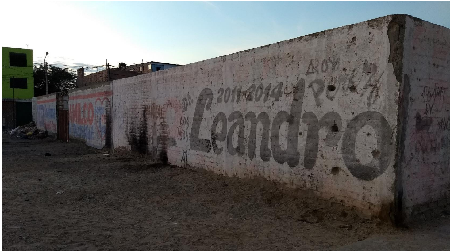
Fotografía 02: Vista panorámica del cerco perimétrico del centro infantil de atención integral Mi Buen Jesús, en el pueblo joven 7 de julio, distrito de Nuevo Chimbote, provincia del Santa, departamento de Ancash.
