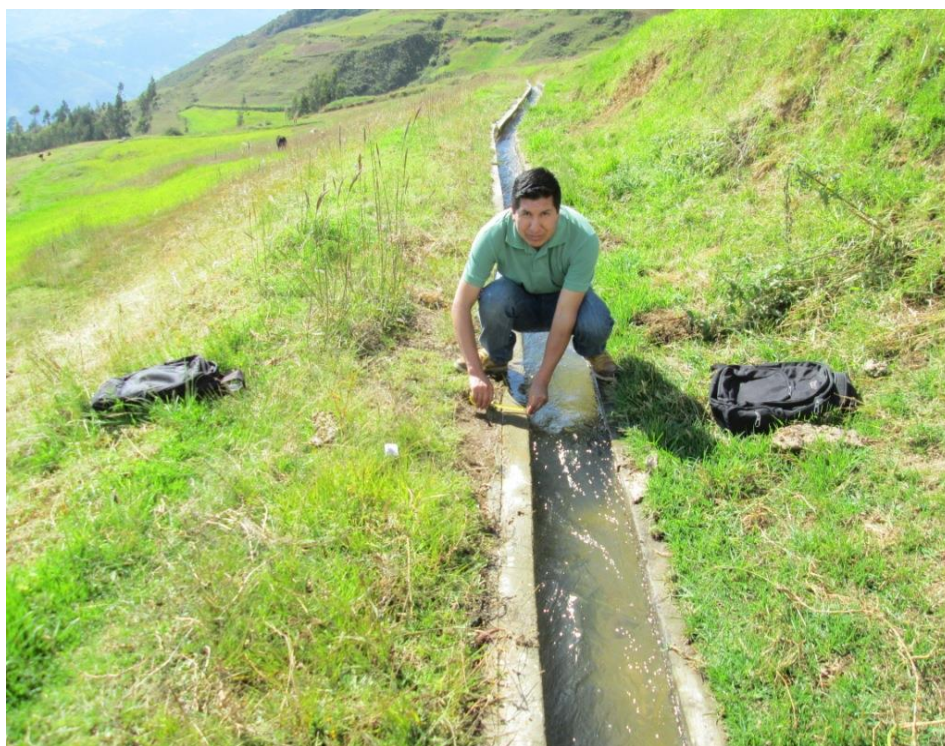
Vista de las actividades de toma de medidas de las secciones del canal de riego.
