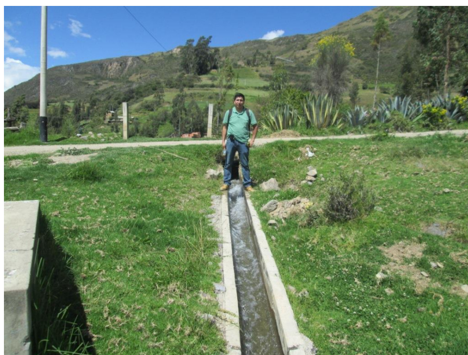
Vista del canal de riego de Huarmey en la parte más baja del trayecto.
