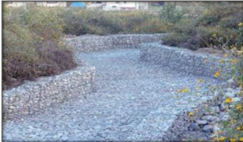
Figura 9. Revestimiento de canal con gaviones.
