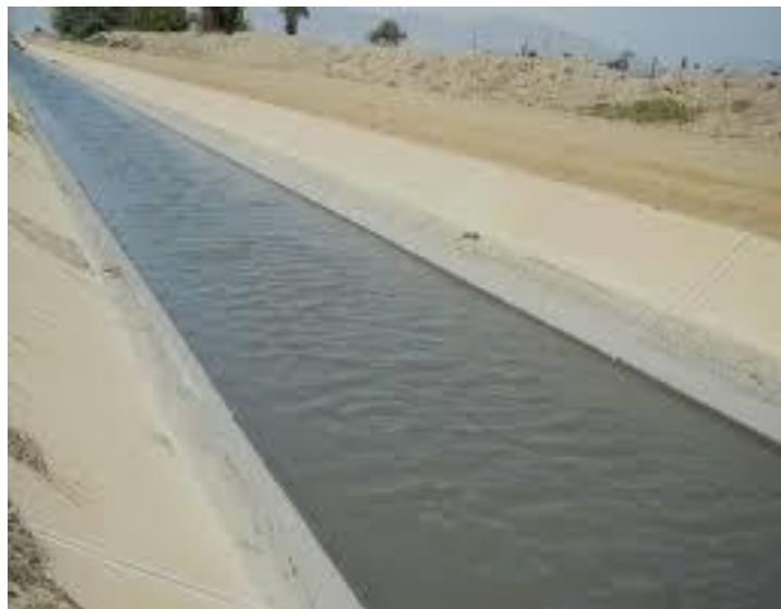
Figura 01. Canal de conducción abierta.
