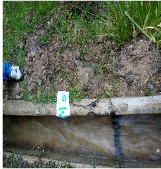
Figura 10: Hundimiento
