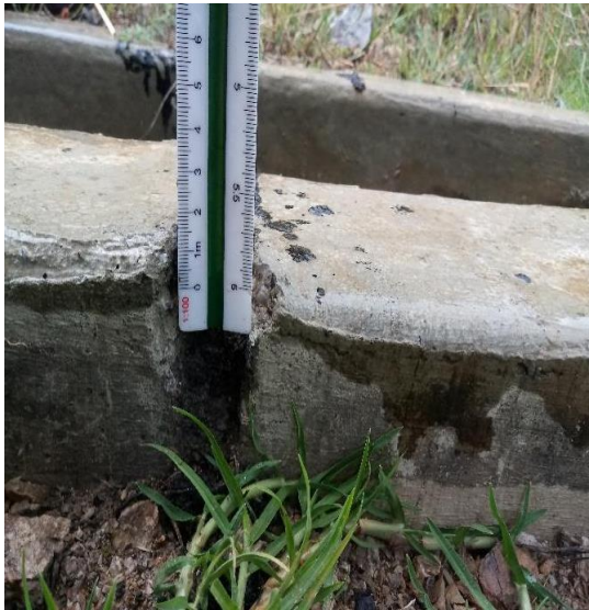
Figura 17: Hundimiento
