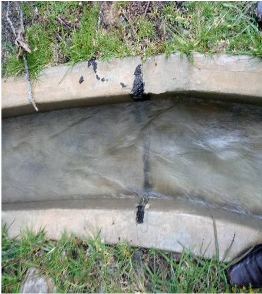
Figura 13: Fisuras
