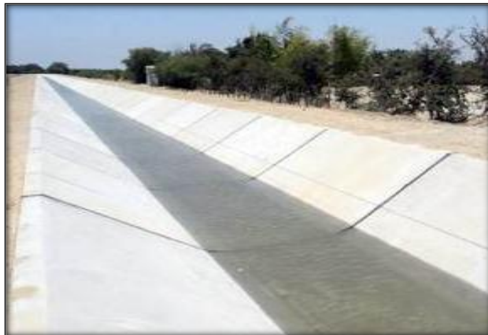
Figura 7. Revestimiento de canal con concreto.
