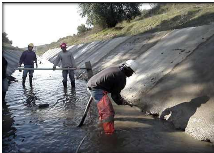
Figura 8. Revestimiento de canal con mortero.
