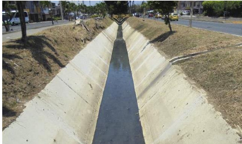
Figura 13. Sedimentación en fondo de canal.
