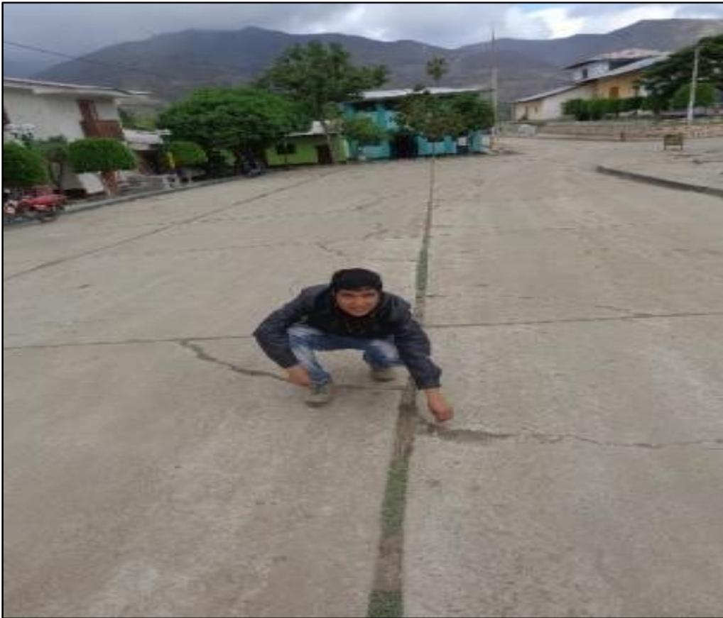
**Gráfico N° 15** : Muestra fisura en esquina de gran escala.
