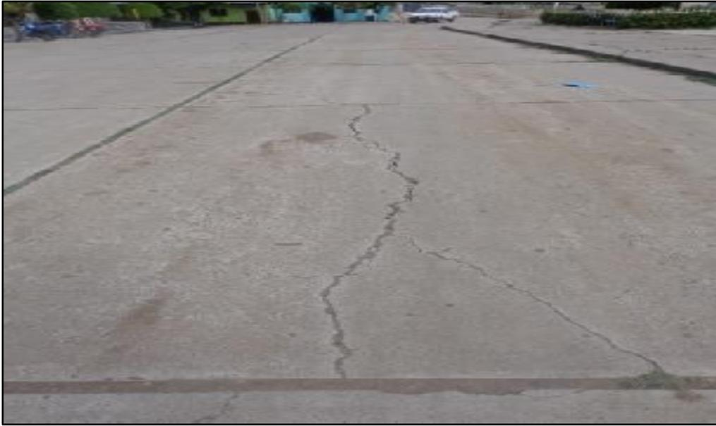
**Gráfico N° 14** : Muestra grietas lineales de alta severidad
