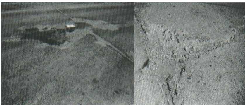
Gráfico 21. Desconchamiento y Descascaramiento de Esquina.
