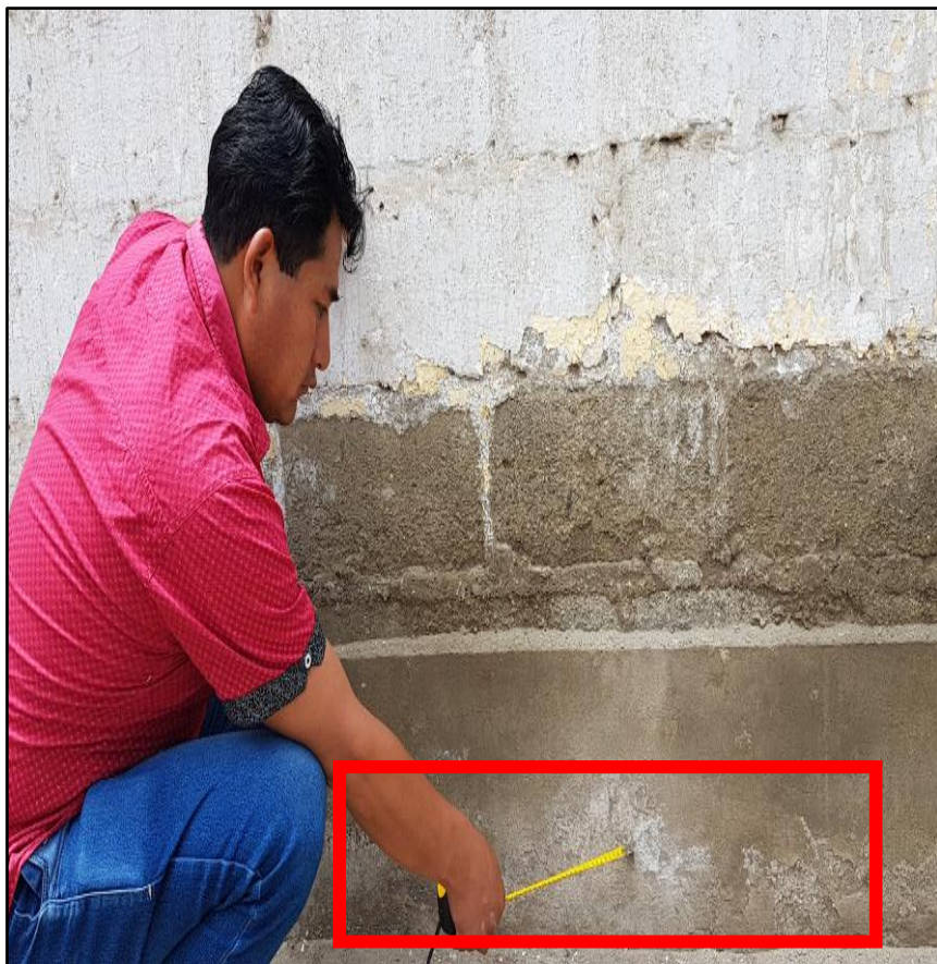
Eflorescencia en muros de albañilería del Cerco Perimétrico del Almacén ex Prona del distrito de Chimbote.
