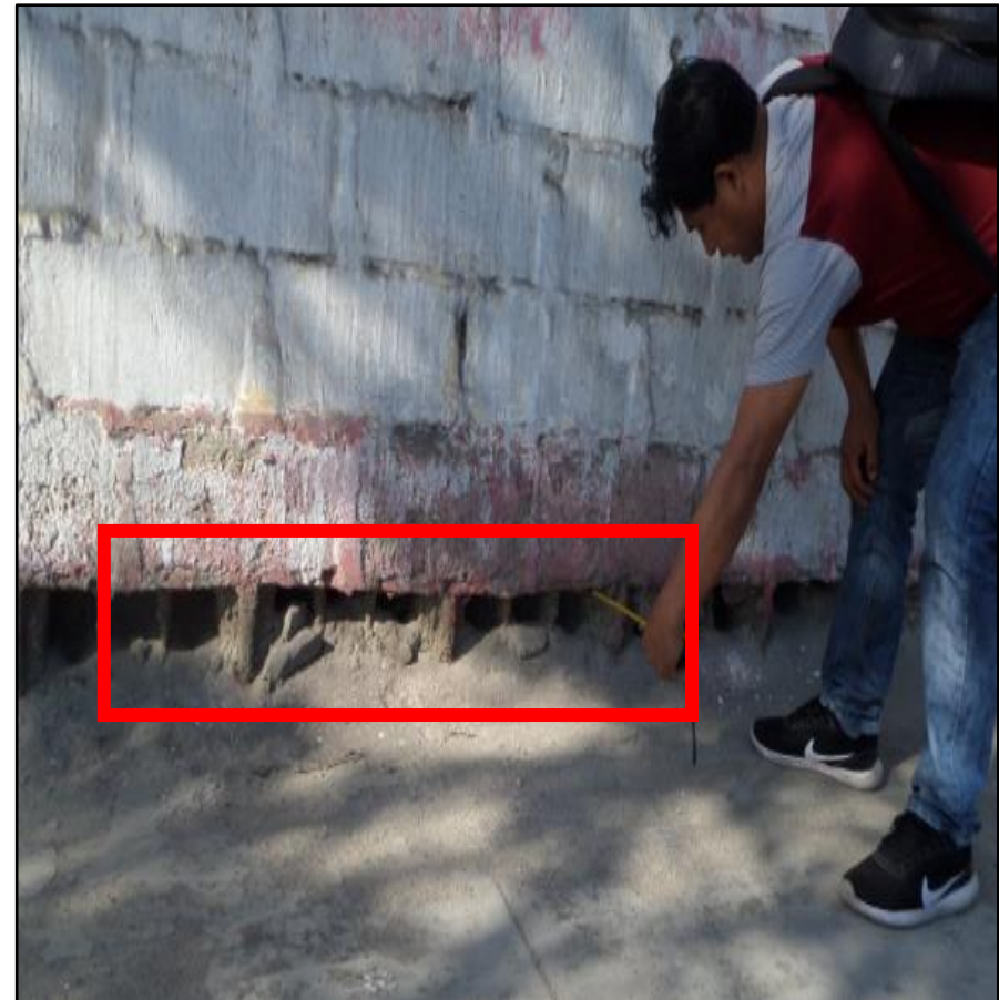
Erosión los muros de albañilería del Cerco Perimétrico del Almacén ex Prona del distrito de Chimbote.
