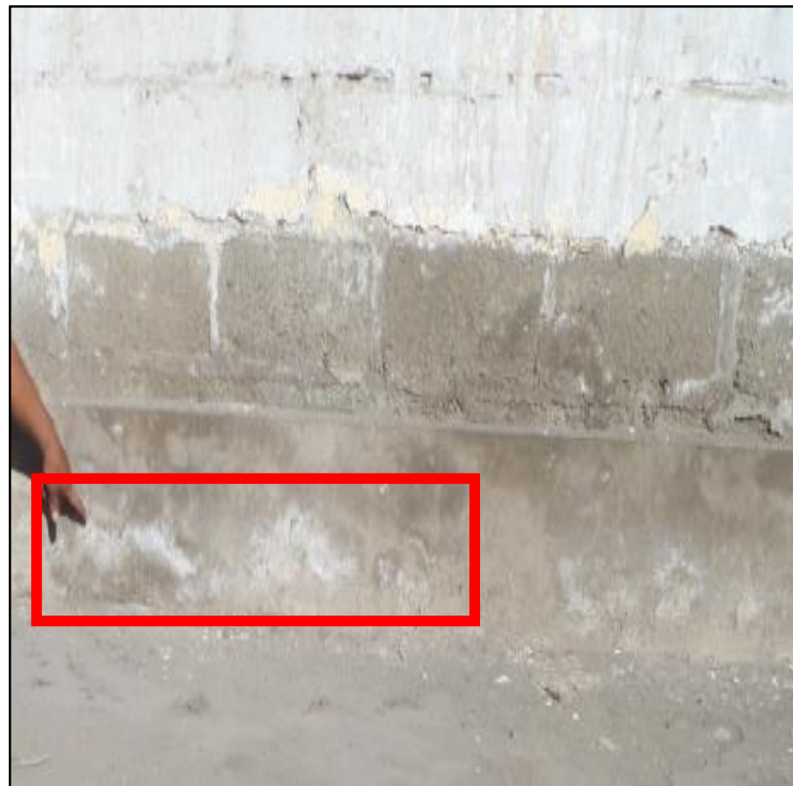
Eflorescencia en muros de albañilería del Cerco Perimétrico del Almacén ex Prona del distrito de Chimbote.
