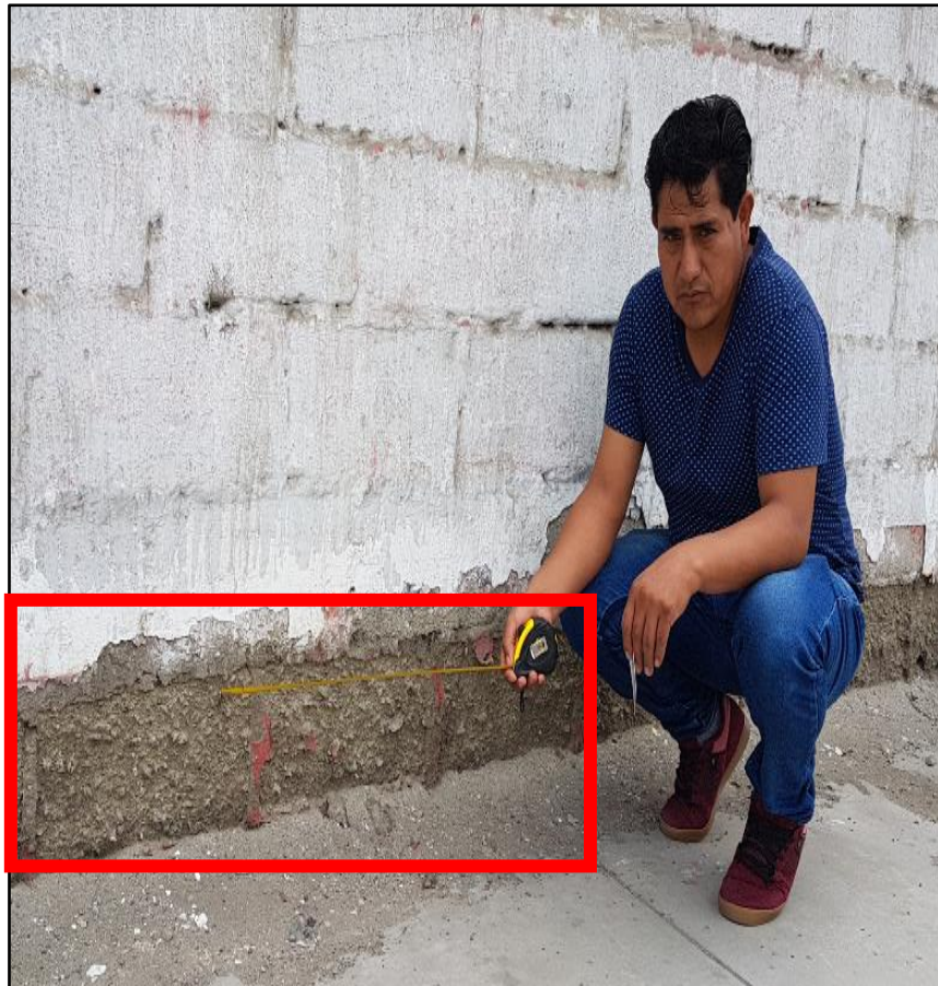
Erosión los muros de albañilería del Cerco Perimétrico del Almacén ex Prona del distrito de Chimbote.
