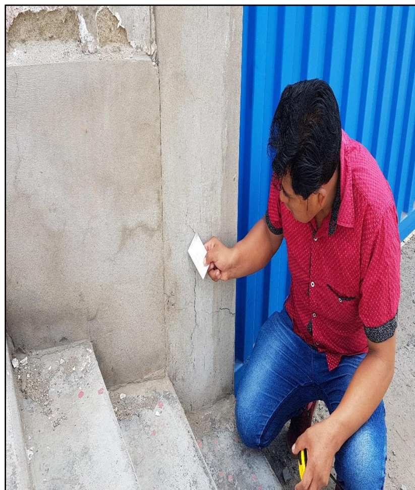
Fisura en muros de albañilería del Cerco Perimétrico del Almacén ex Prona del distrito de Chimbote.
