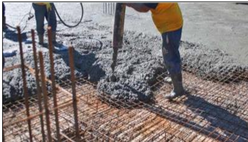
Figura 12. Concreto Armado Nota. Fuente: (Faustino D. 2005) 16
