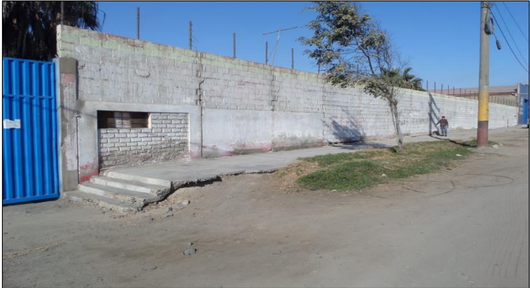
Vista Panorámica lado Derecho del Cerco Perimétrico del Almacén ex Prona del distrito de Chimbote.
