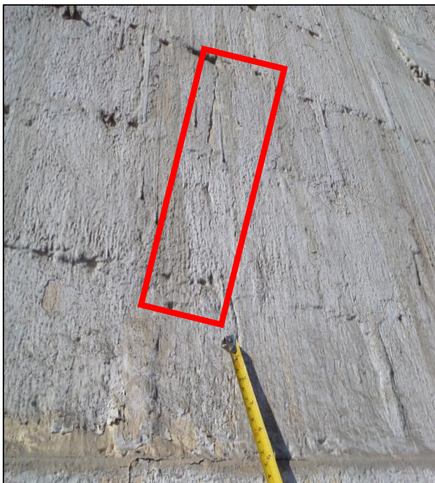
Fisura en muros de albañilería del Cerco Perimétrico del Almacén ex Prona del distrito de Chimbote.
