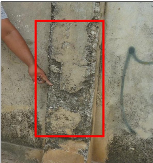
Fotografía 04: Patología Erosión en columna de mortero
