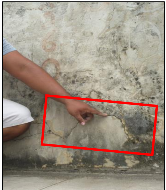
Fotografía 03: Patología Fisura en el muro de albañilería
