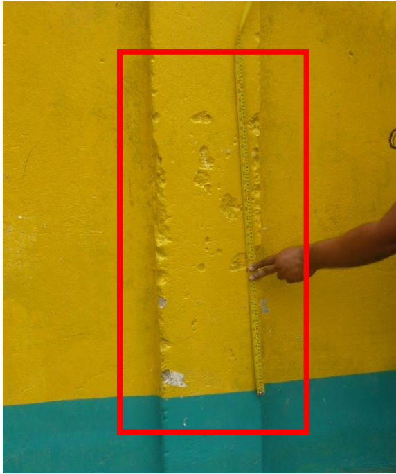
Fotografía 07: Patología Picadura en Columnas de Mortero
