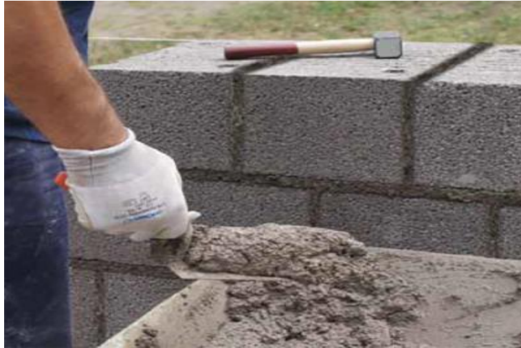
Figura 10.El mortero tiene una adecuada trabajabilidad Nota. Fuente: (Soto J. 2004) 13
