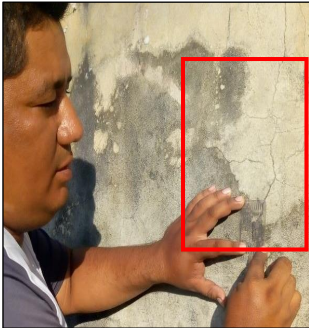
Fotografía 03: Patología Fisura en el muro de albañilería
