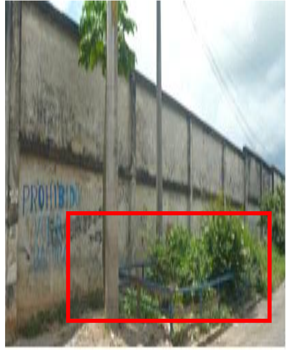
Fotografía 05: Patología Organismos en el muro de albañilería
