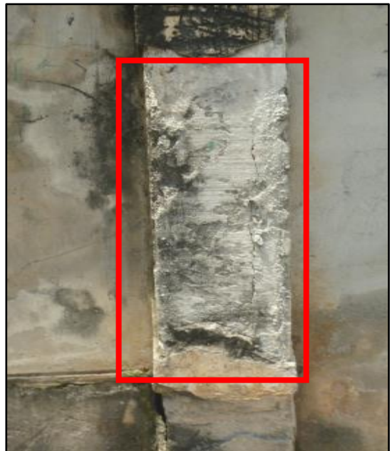
Fotografía 04: Patología Erosión en columna de mortero
