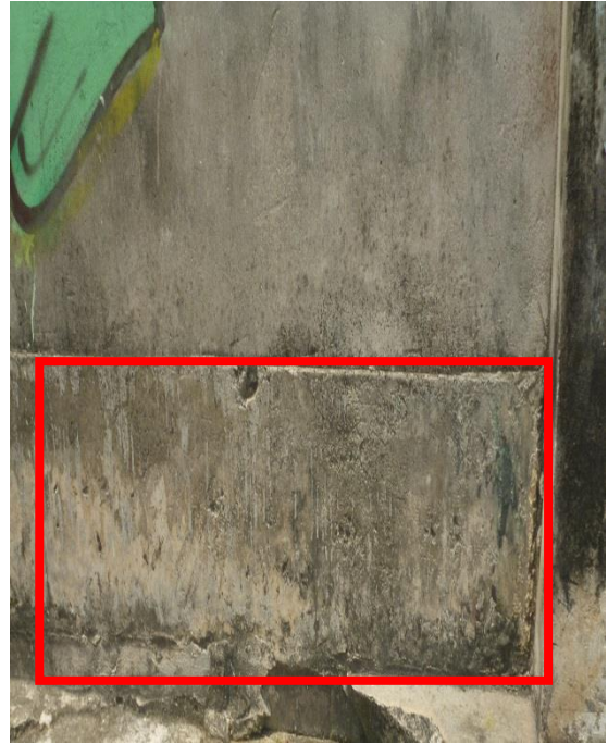
Fotografía 07: Patología Picadura en Columnas de Mortero
