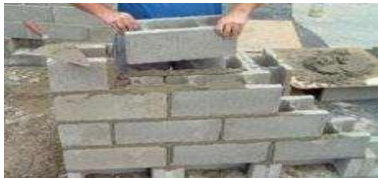
Figura 13. Colocación de ladrillos para muros con concreto simple Nota. Fuente: (Flores F. 2014) 11
