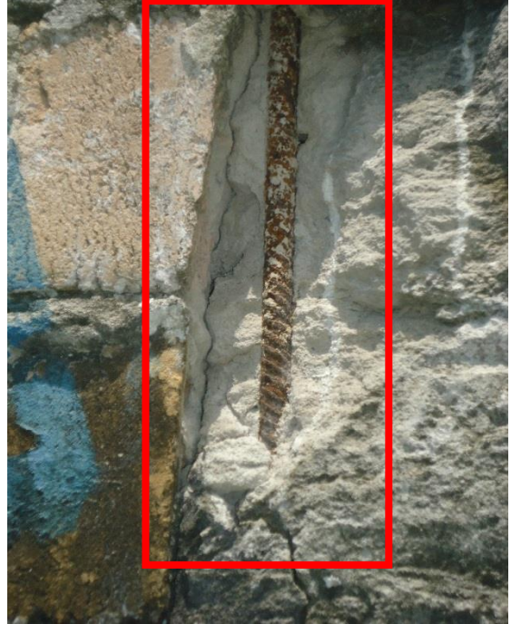
Fotografía 06: Patología Corrosión en Columnas de Mortero
