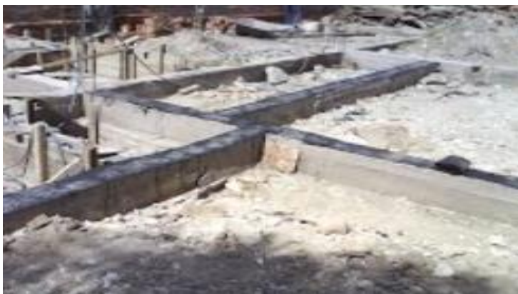
Figura 8. Sobrecimiento de muro de albañilería
