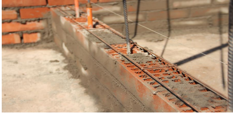
Figura 3. Albañilería Armada Nota. Fuente: (Guipúzcoa I. 2011) 8
