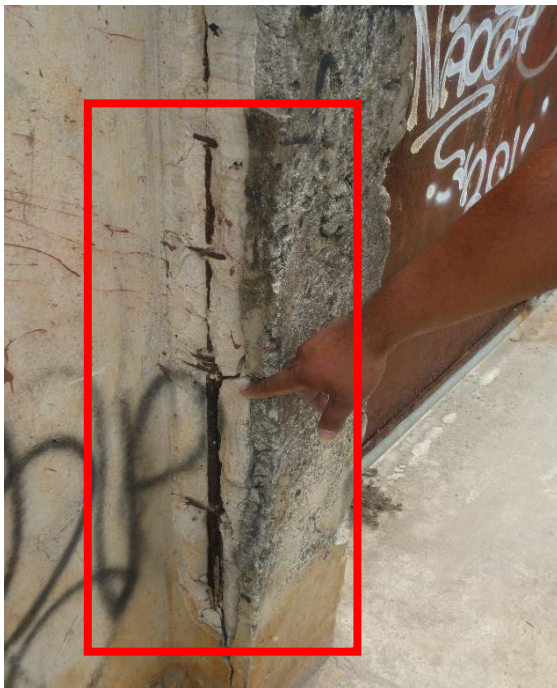
Fotografía 06: Patología Corrosión en Columnas de Mortero
