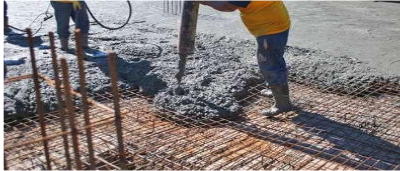
Figura 14. Vaciado de una losa de concreto armado Nota. Fuente: (Flores F. 2014) 11
