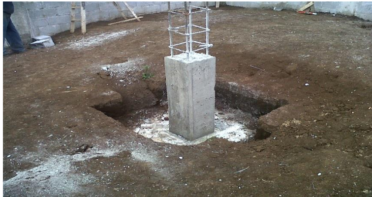
Figura 5. Toda columna nace desde la cimentación
