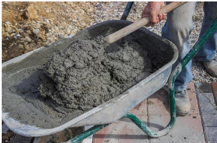
Figura 12. Batido del mortero Nota. Fuente: (Soto J. 2004) 13
