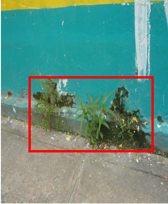
Fotografía 05: Patología Organismos en el muro de albañilería
