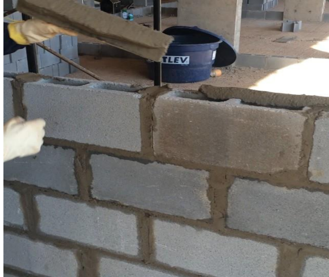
Figura 9. Fraguado de mortero en bloques de concreto Nota. Fuente: (Soto J. 2004) 13
