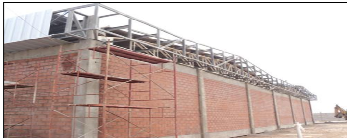
Figura 4. Albañilería confinada Nota. Fuente: (Estévez J. 2014) 10
