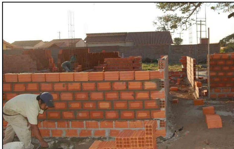
Figura 10. Pegado de ladrillos con mortero Nota. Fuente: (Castillo E. 2015) 16
