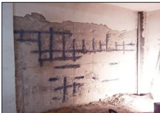
Figura 31. Corrosión Nota. Fuente: (León A. 2015) 24
