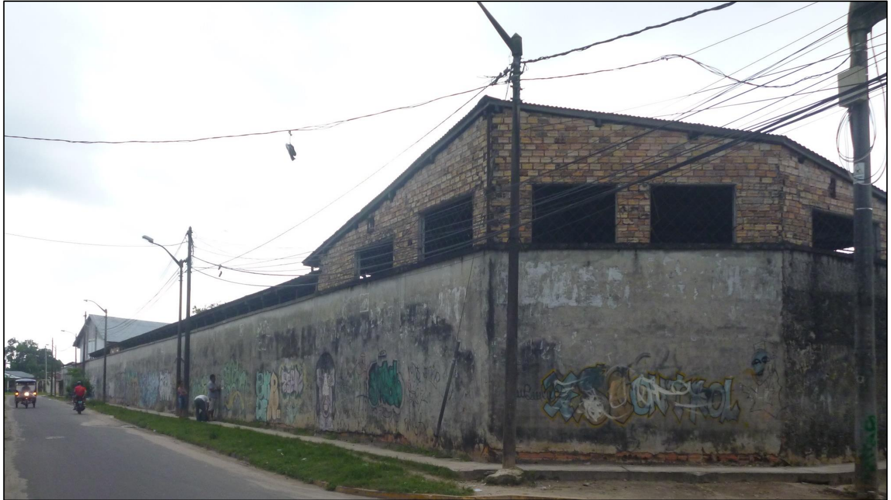
Anexo 02: Fotografía Panorámica Lado Derecho
