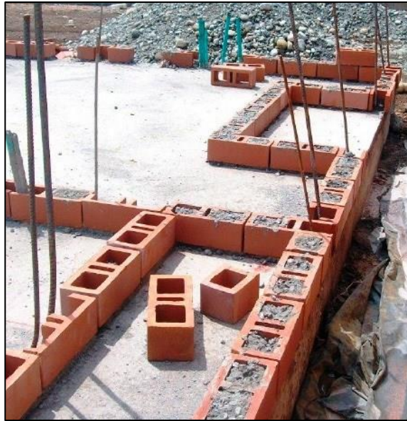
Figura 2. Albañilería armada Nota. Fuente: (Guipúzcoa I. 2011) 10
