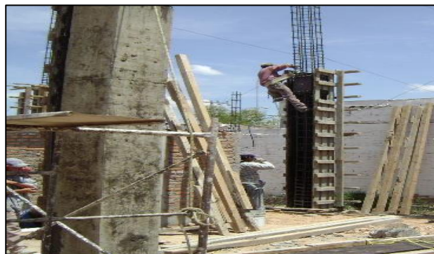
Figura 5.Columna de concreto armado Nota. Fuente: (Villarreal G, 2009) 12
