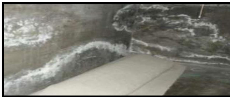
Figura 13: Presencia de Eflorescencia en muros.
