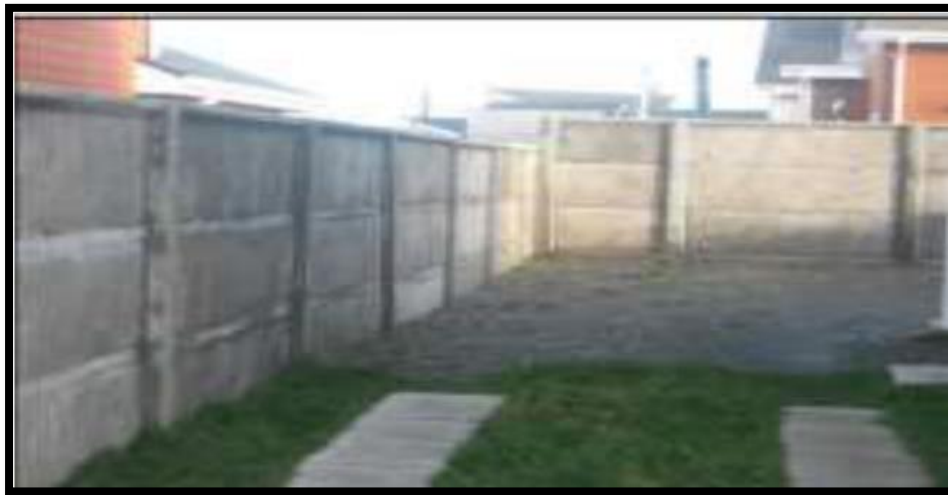
Figura 1: Cerco perimétrico de albañilería.
