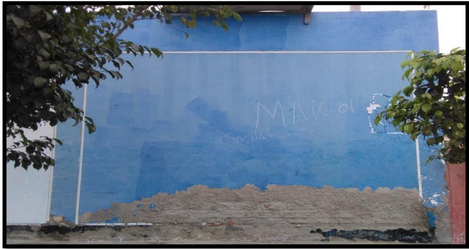
Figura 8: Presencia de Erosión Física. Nota. Fuente: Elaboración propia (2018).
