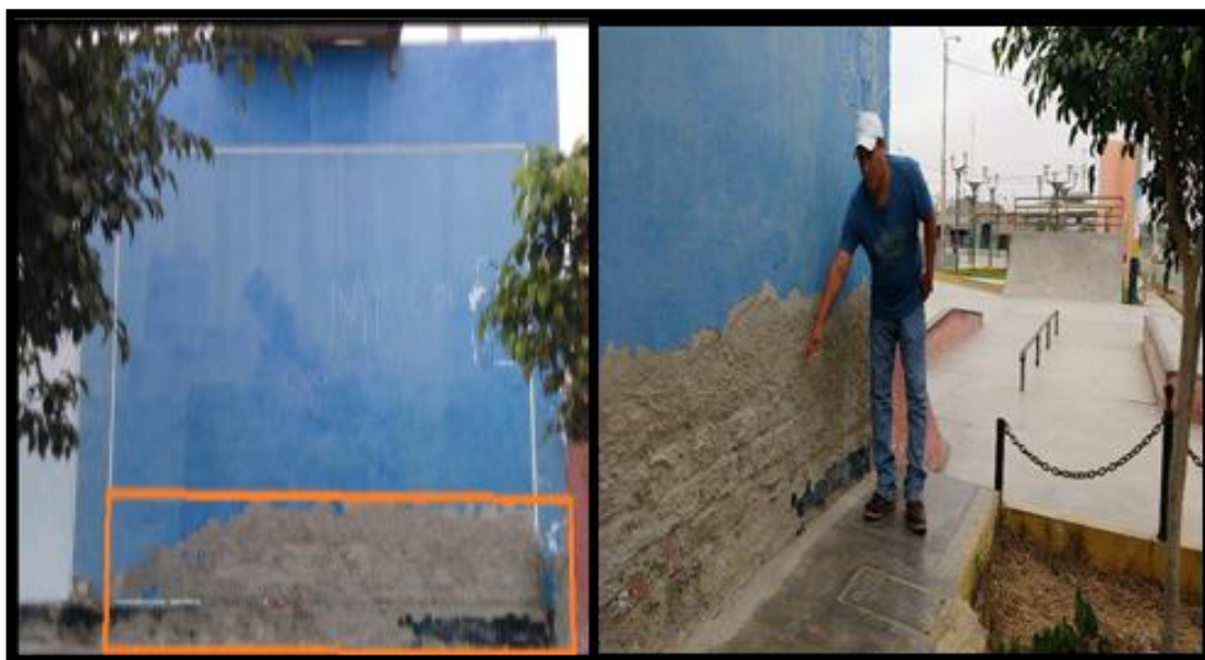
Fotografía 6: Patología de Erosión en muros y sobrecimiento del local Comunal en la Unidad Muestral 4.
