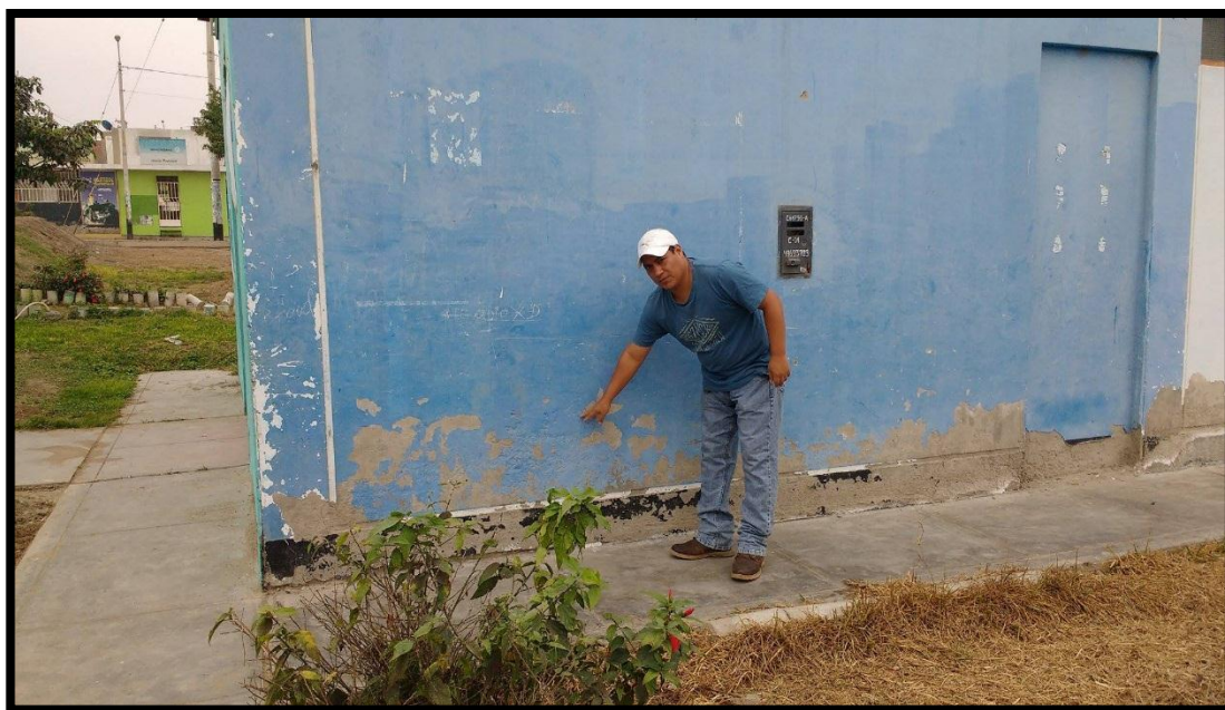
Fotografía 5: Patología de Erosión en muros y sobrecimiento del local Comunal en la Unidad Muestral 1.
