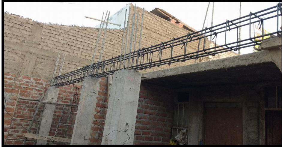
Figura 7: Columna de concreto armado. Nota. Fuente: Elaboración propia (2018)
