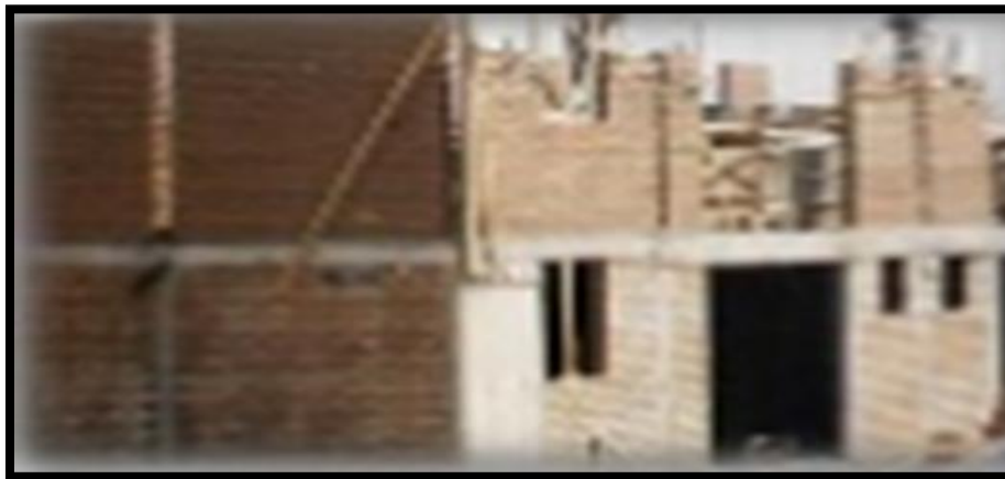
Figura Albañilería Confinada.
