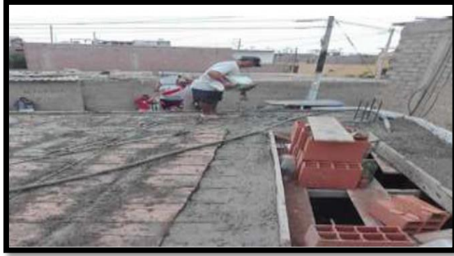
Figura 5: Vaciado de concreto armado en losa aligerada. Nota. Fuente: Elaboración propia (2018)
