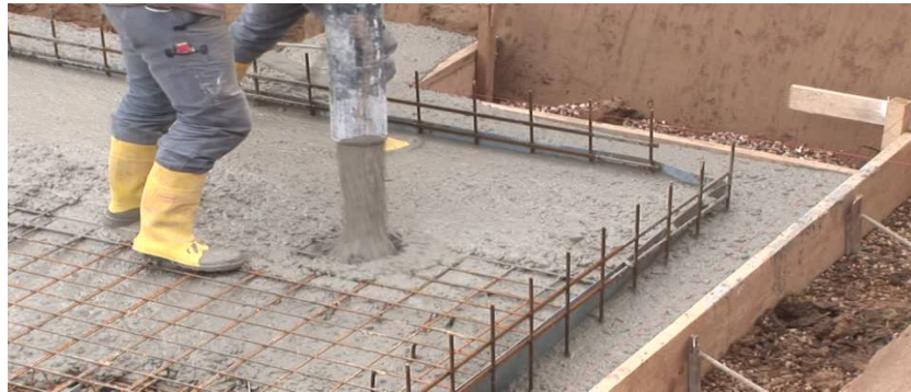
Figura 10. Aplicación del concreto Nota. Fuente: (Vasallo F. 2016) 16
