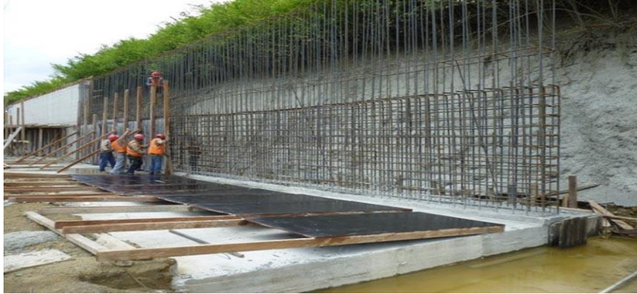
Figura 13. Concreto Armado Nota. Fuente: (Altamirano J. 2015) 18
