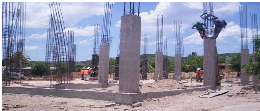
Figura 6. Columnas de concreto armado Nota. Fuente: (Fernández M. 2011) 13
