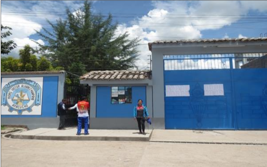
Fotografía 1: Cerco perimétrico del Instituto Superior Tecnológico Monseñor Víctor Álvarez Huapaya ubicado en el sector de Miraflores del distrito de San Juan Bautista, provincia de Huamanga, región Ayacucho.
