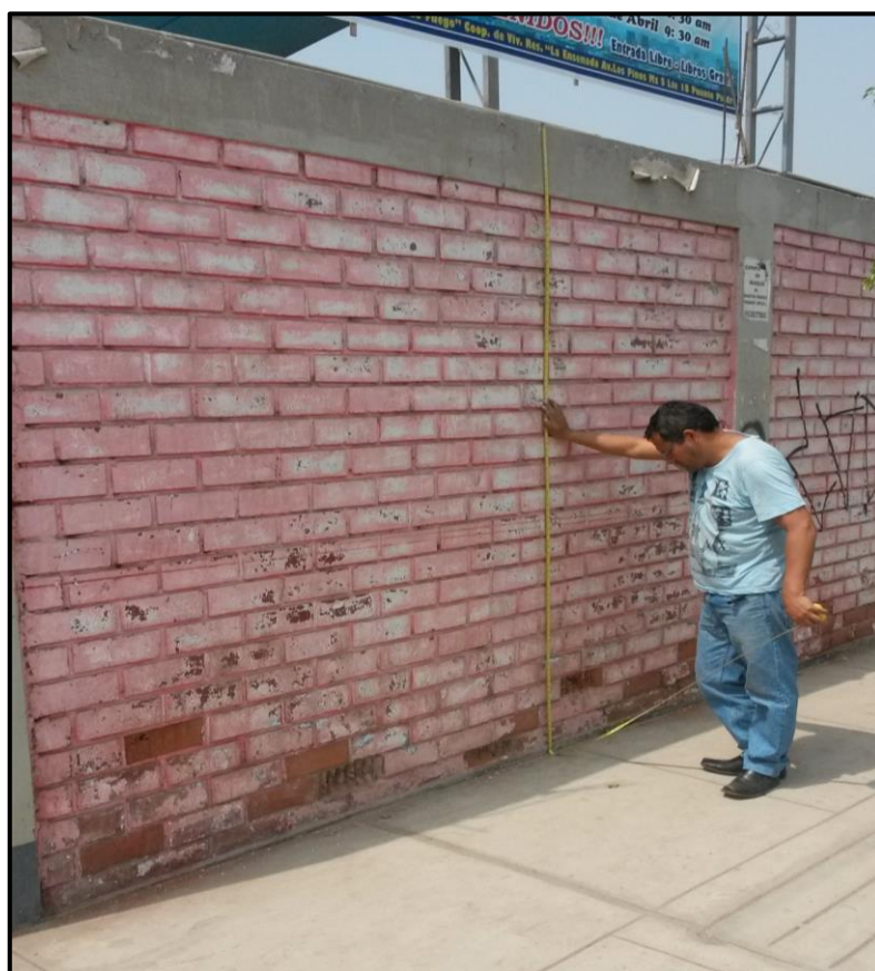
Fotografía 06: Midiendo la altura del muro de albañilería.
