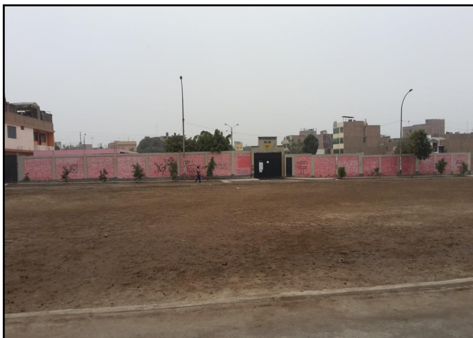
Fotografía 01: vista exterior de la Institución Educativa 8178.
