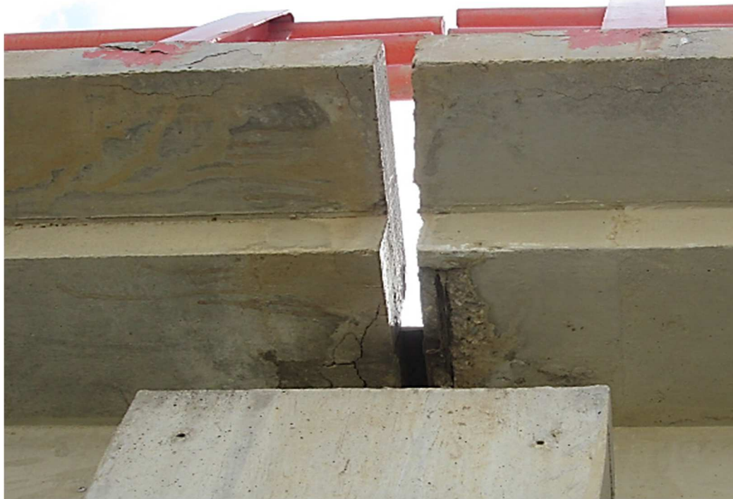
Anexo 08: Vista de losa (Daño en grado 03)
