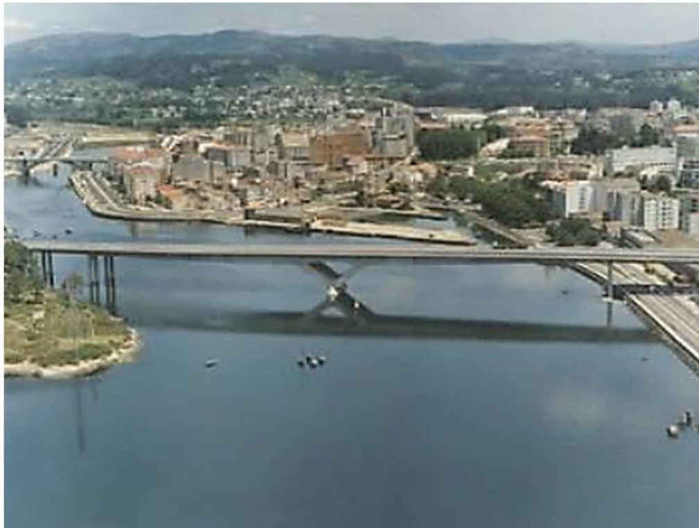
Figura 01: Ponte Vedra, España – Luz de vano mayor a 50 m
