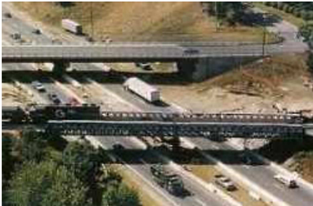
Figura 02: Puente Caminero y Ferroviario
