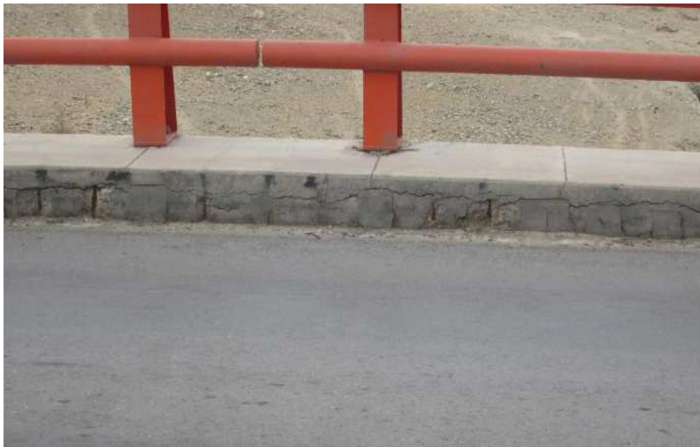
Anexo 10: Vista de grietas en vereda y exposición de armadura (Grado 03)
