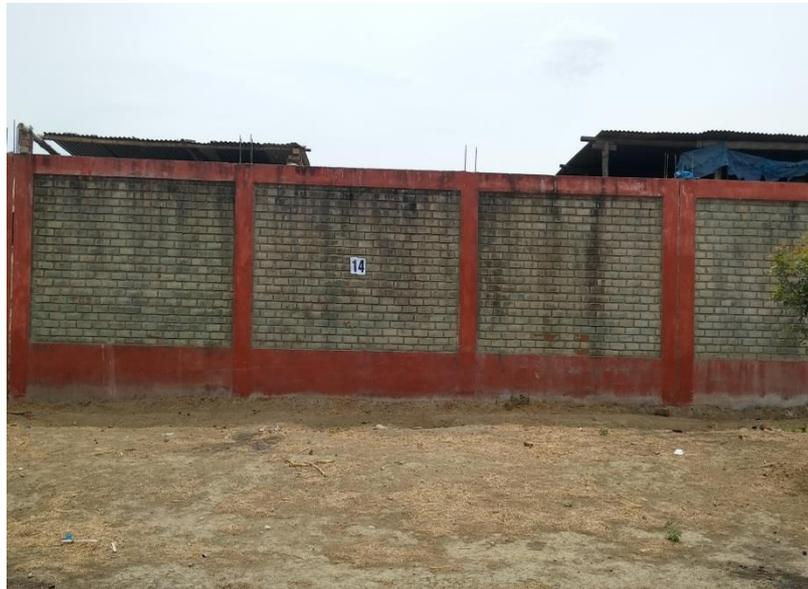
Imagen 12: Cerco perimétrico de albañilería confinada.
