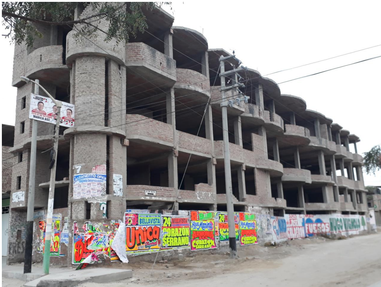
Figura 08: Vista panorámica del exterior del edificio apartado.
