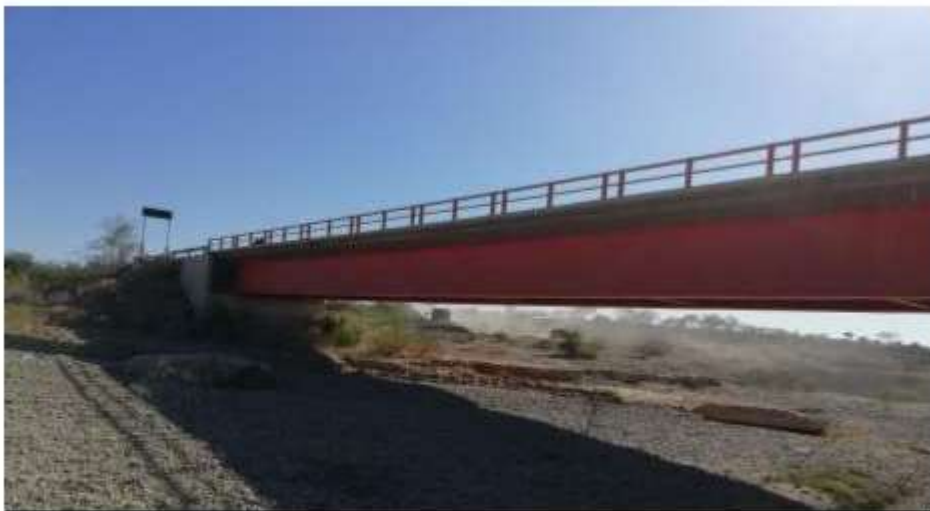
Fig. 02 Vista del puente Sojo
