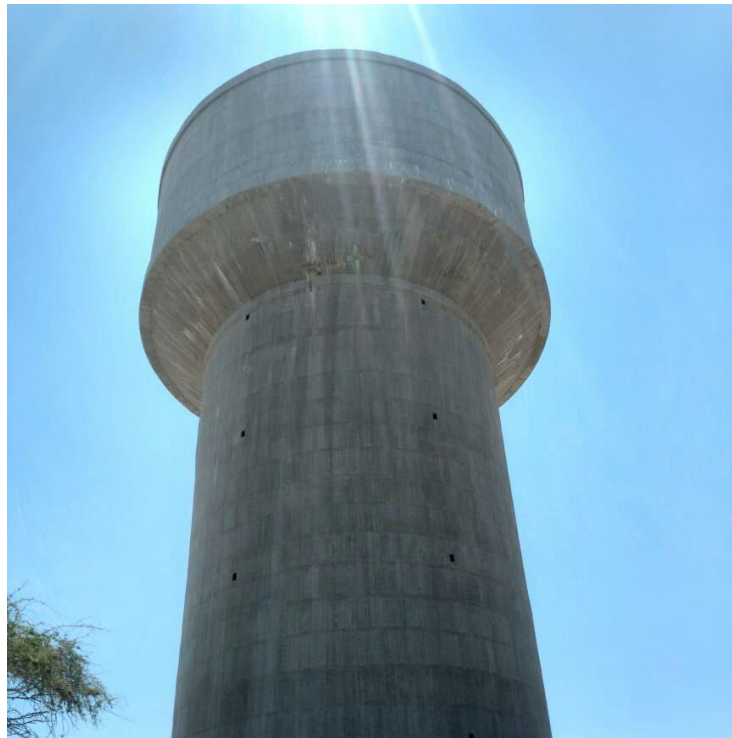
Gráfico 3: Tanque elevado de concreto armado
