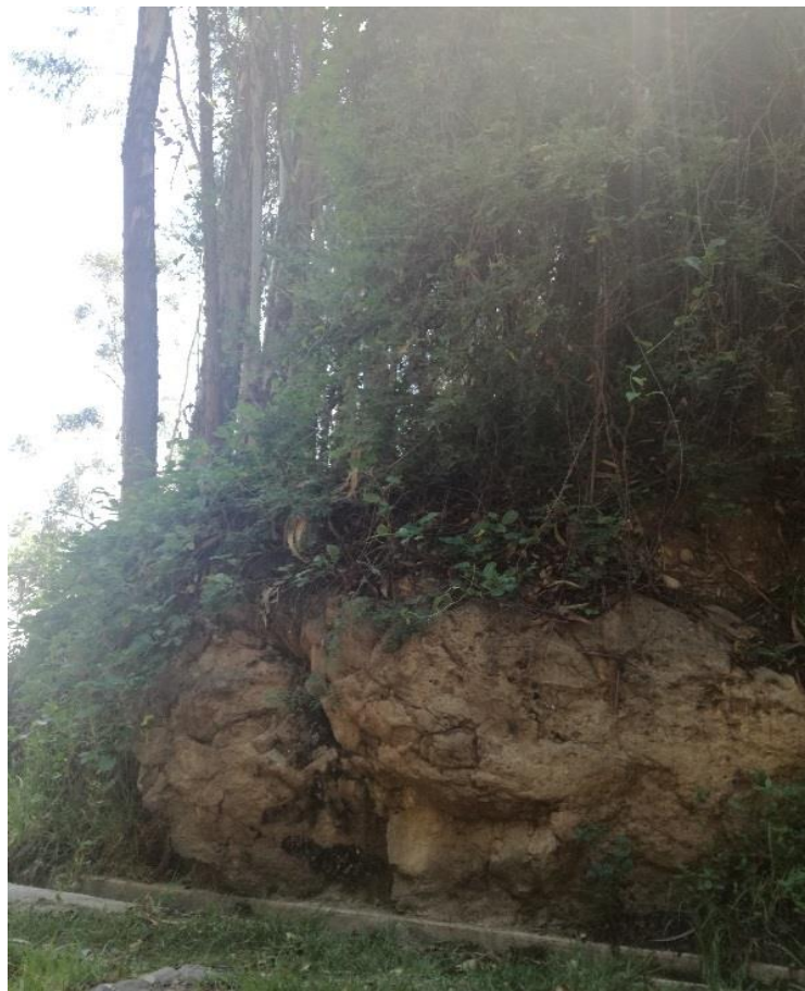
Imagen 29: Rocas muy cercanas al canal de riego U.M N° 3
