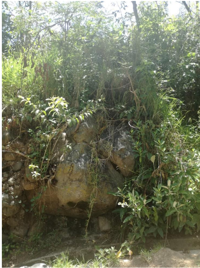
Imagen 32: Rocas muy cercanas al canal de riego U.M N° 8
