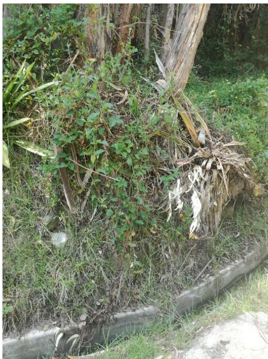
Imagen 30: Rocas muy cercanas al canal de riego U.M N° 2
