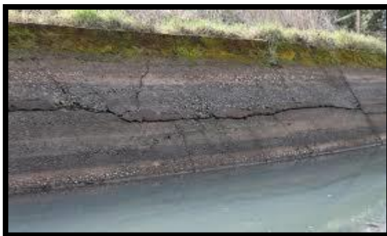
Figura 9. Agrietamientos estructurales.
