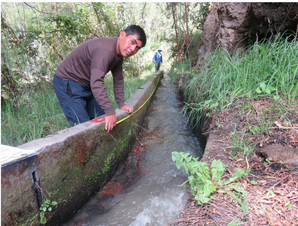
Fotografía 2. Medición de progresivas de canal de riego Mosotoma
