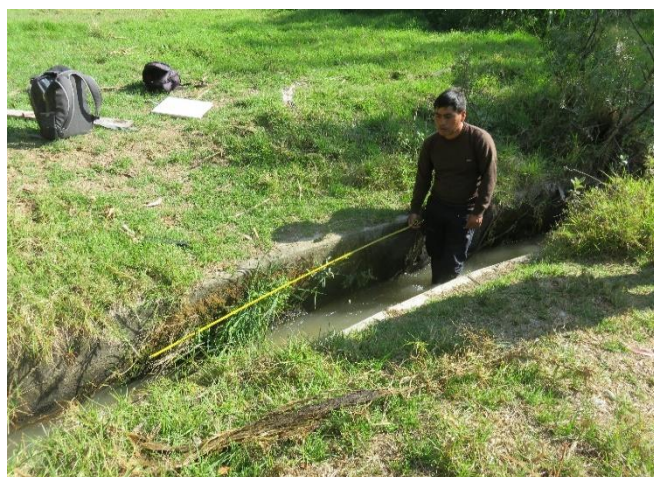
Figura 11. Detalle de las patologías de la unidad muestral 01
