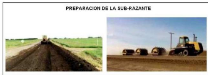
Imagen 4. Etapas para la preparación de la subrasante
