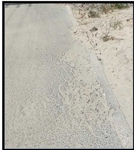
En la imagen se muestra la falla de piel de cocodrilo. Fuente propia
