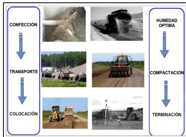
Imagen 3. Etapas para la preparación de la base.
