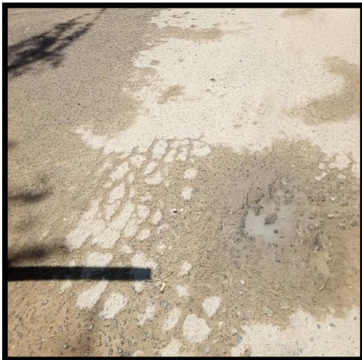
En la imagen se muestra la falla de piel de cocodrilo. Fuente propia
