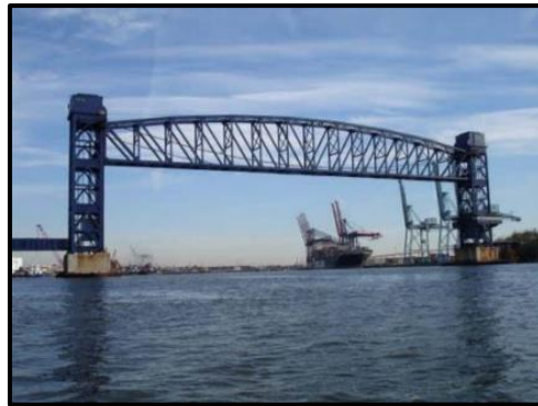
Figura 24: Puente de desplazamiento vertical - Arthur Kill (Nueva York).
