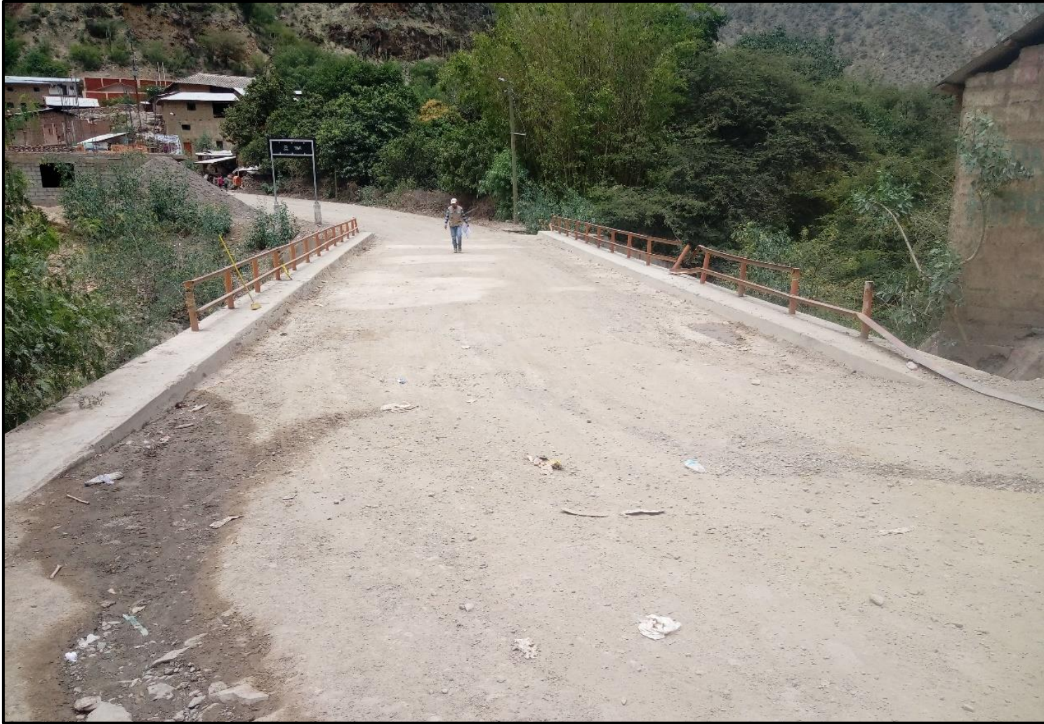
Fotografía N° 2. Vista longitudinal del puente vehicular Mamahuaje.
