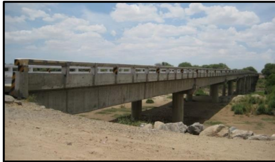
Figura 13: Puente Miguel Grau-Piura.
