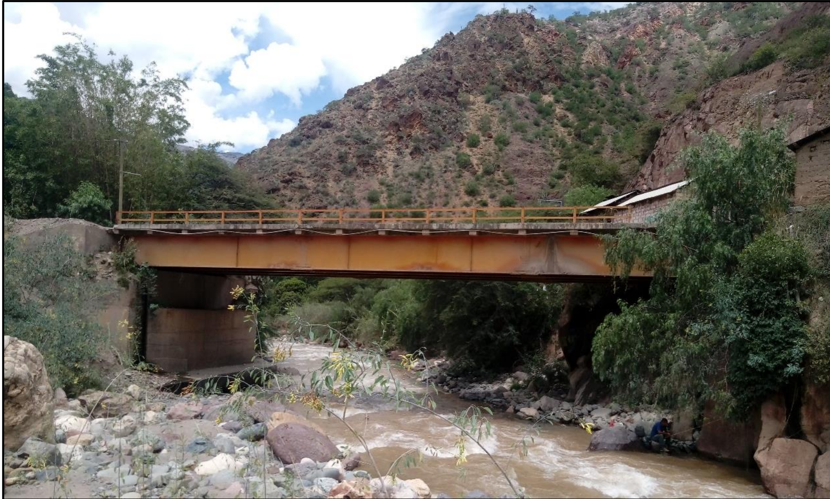
Fotografía N° 1. Vista panorámica del puente vehicular Mamahuaje.
