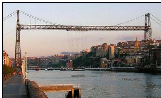
Figura 25: Puente transbordador – Vizcaya (Portugalete y Guecho).
