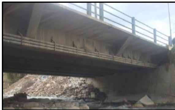
Figura 9: Puente confraternidad internación Este-Huaraz. Nota. Fuente: Villacorta A. (2014).
