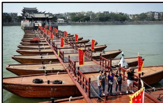
Figura 27: Puente flotante – Guangji (China). Nota. Fuente Wikipedia (2018).
