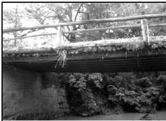
Figura 1: Puente con vigas de acero y troncos. Nota. Fuente: Mascia N, Sartorti A. (2010).
