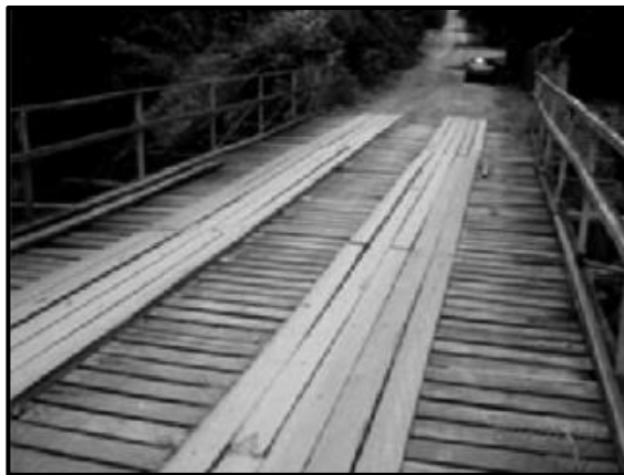
Figura 3: Puente de madera. Nota. Fuente: Mascia N, Sartorti A. (2010).
