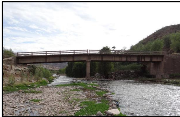
Figura 16: Vista lateral del Puente Chanchará-Ayacucho.
