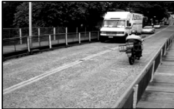
Figura 2: Puente de concreto armado y veredas de madera. Nota. Fuente: Mascia N, Sartorti A. (2010).
