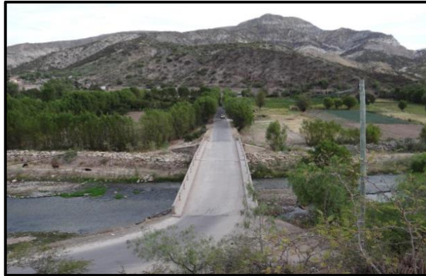
Figura 15: Vista panorámica del Puente Chanchará-Ayacucho.
