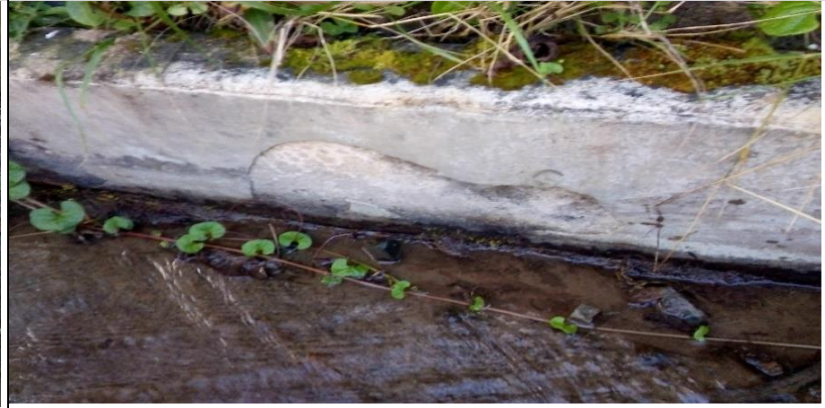
MURO IZQUIERDO DEL CANAL
