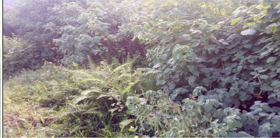
MURO IZQUIERDO DEL CANAL
