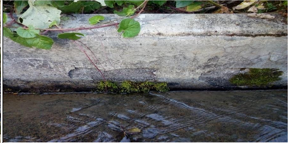
MURO IZQUIERDO DEL CANAL
