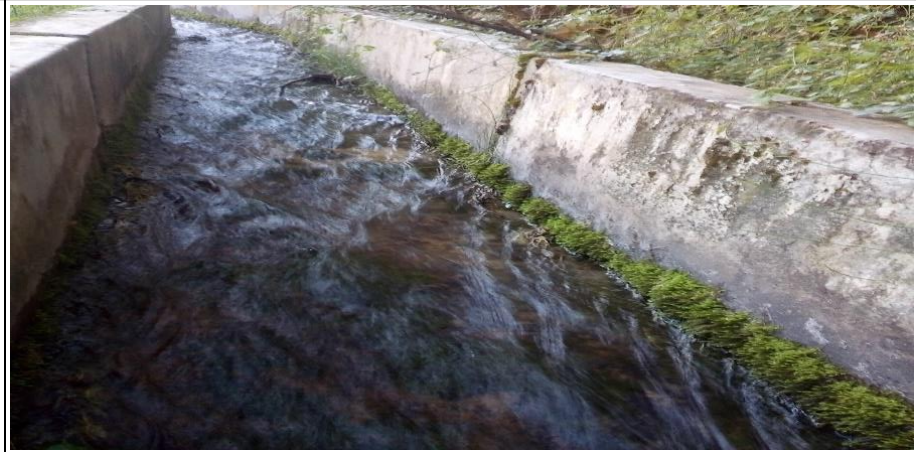
MURO IZQUIERDO DEL CANAL
