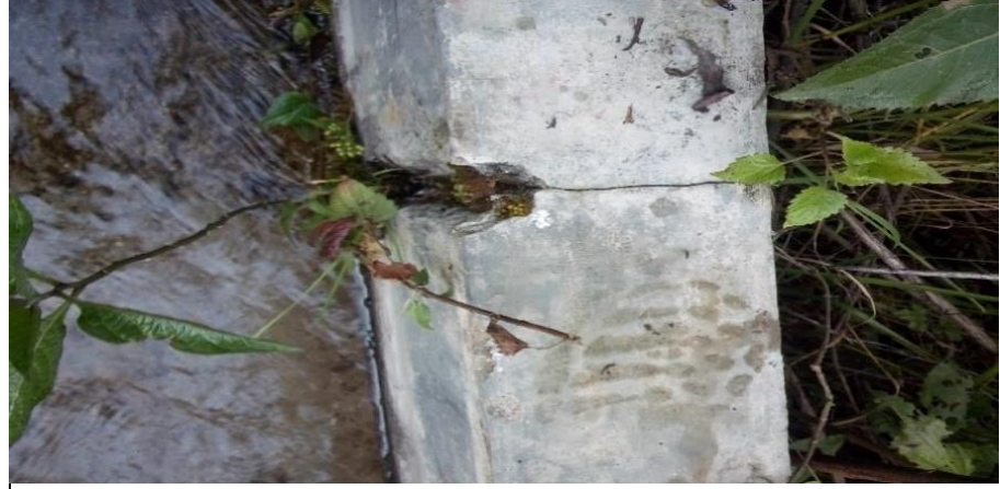
MURO IZQUIERDO DEL CANAL
