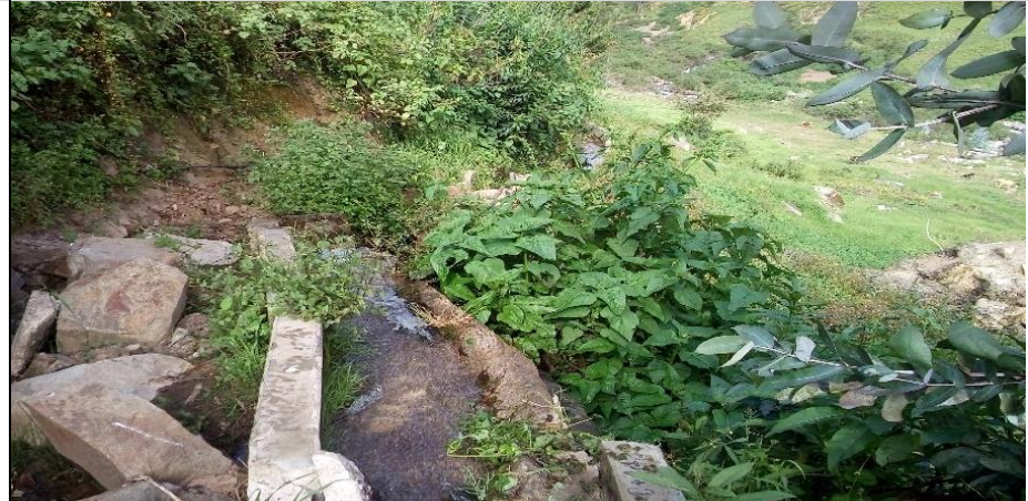
MURO IZQUIERDO DEL CANAL
