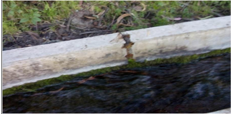
MURO IZQUIERDO DEL CANAL
