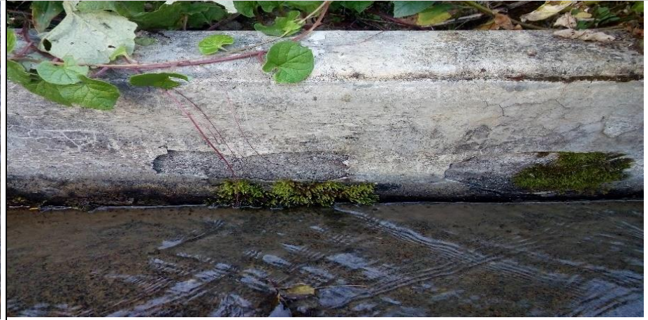
MURO IZQUIERDO DEL CANAL
