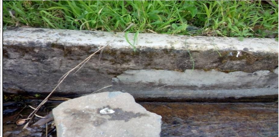
MURO IZQUIERDO DEL CANAL
