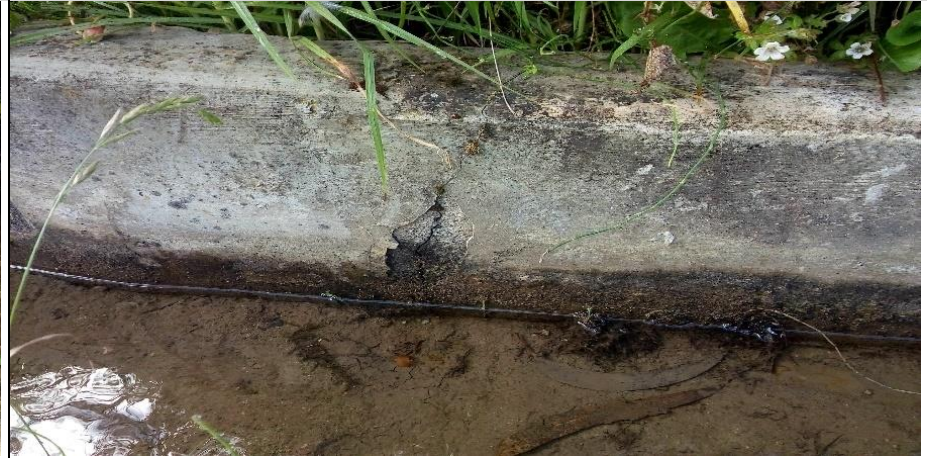
MURO IZQUIERDO DEL CANAL
