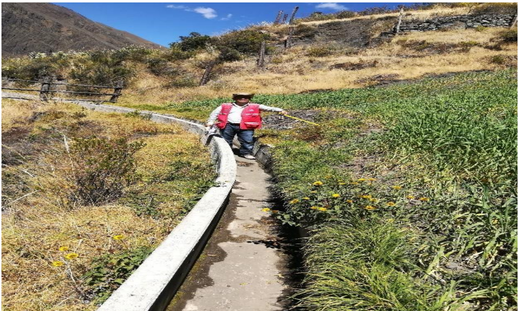
Fotografía 02- vista muro derecho midiendo impacto en el canal de irrigación Túpac
