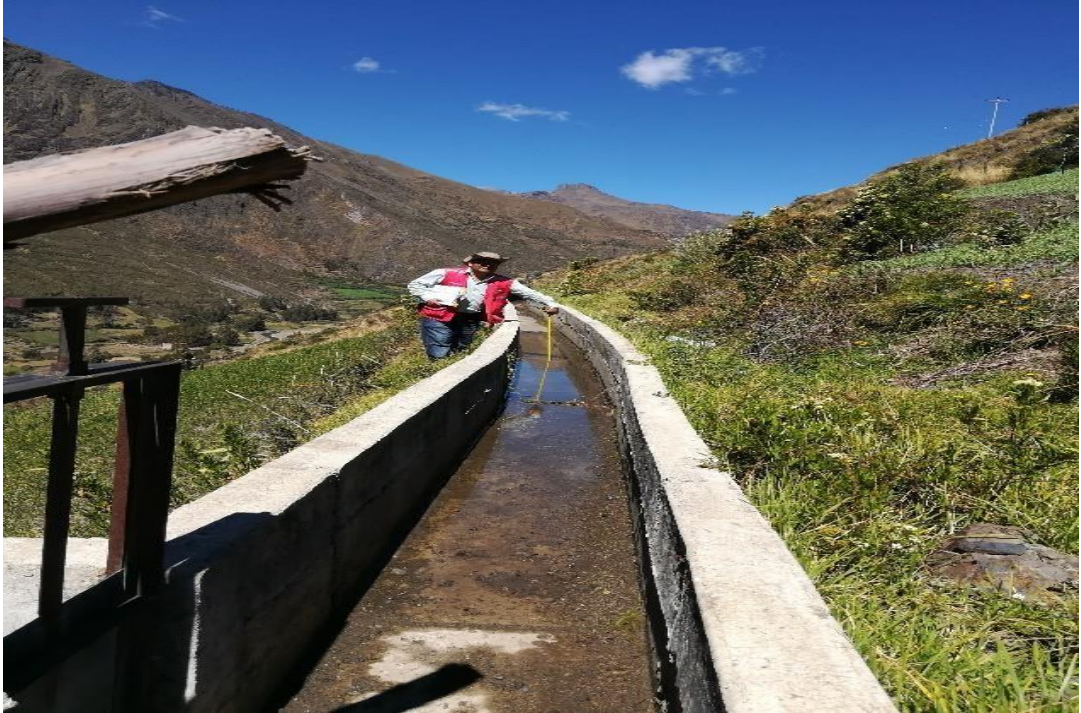
Fotografía 03- vista muro izquierdo midiendo las grutas en el canal de irrigación Túpac Amaru de la localidad de Racrachaca distrito de Aquia, provincia de Bolognesi, departamento de Ancash,
