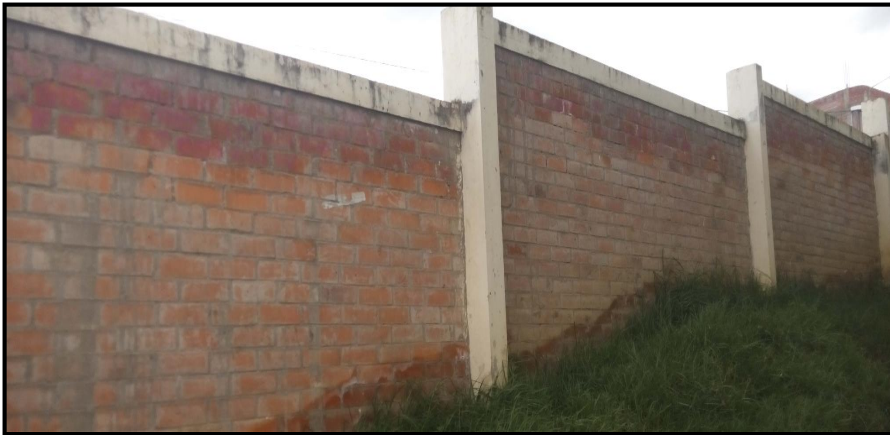
Fotografía 03: Tramo N° 02-08 (Interno) del cerco perimétrico de la Institución Educativa
