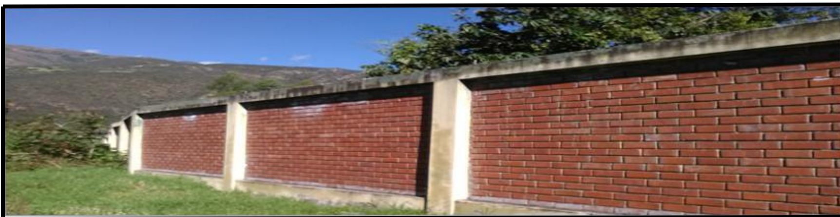
Fotografía N° 03 – (Externo e Interno) del cerco perimétrico del Estadio Municipal de Mancos
