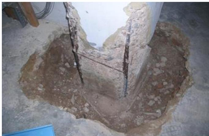
Imagen 0 6: Delaminación en columna
