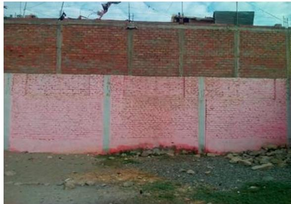
Imagen 08: Humedad en muro
