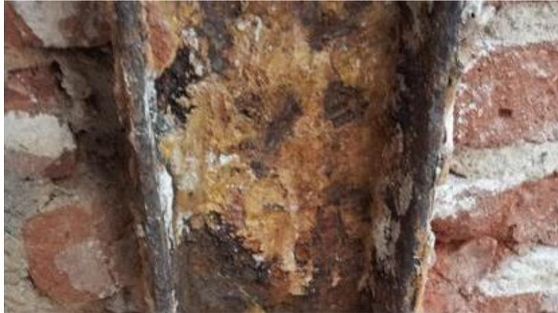
Imagen 0 10: Corrosión del acero en columna
