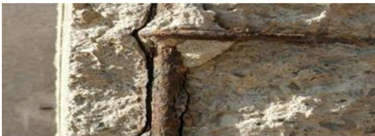
Imagen 09: Oxidación de acero en columna
