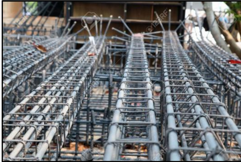
Figura 12. Acero reforzado para anclajes de columnas. Fuente: Thalerngsak Mongkolsin (2015).
