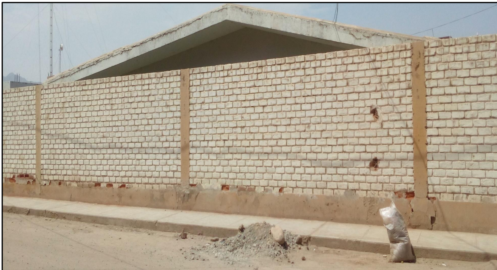
Fotografía 3. Tramo 2 – 3 del cerco perimétrico del Hospital Provincial de Virú, ubicado en el distrito de Virú, provincia de Virú, región de La Libertad
