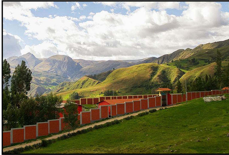
Figura 3. Cerco perimetral de la I.E 80625 - La Libertad. Fuente: Coinso SAC (2016).
