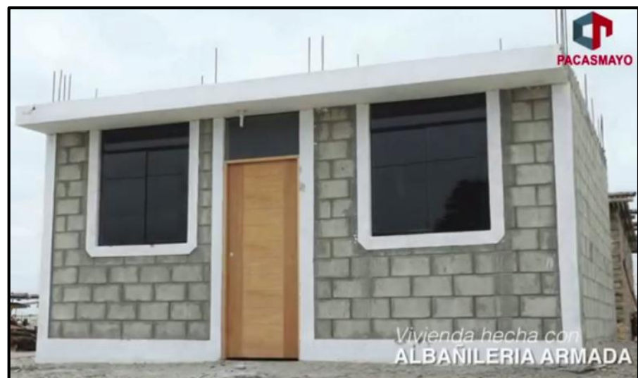
Figura 5. Vivienda hecha con albañilería armada. Fuente: Pacasmayo (2018).
