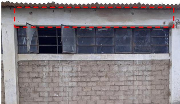
*Figura 4.* Viga peraltada de concreto armado. – Fuente: Creación propia.
