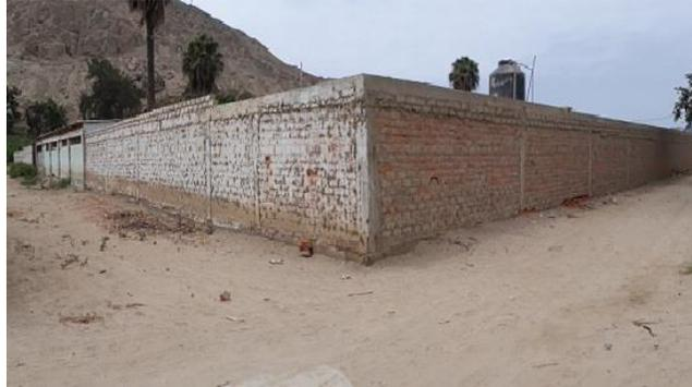
*Figura 9.* Cerco perimétrico de albañilería confinada. – Fuente: Creación propia.
