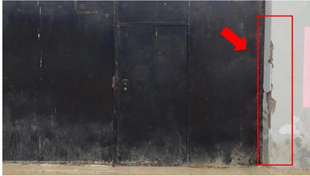
**Figura 13.** Desprendimiento del revestimiento en columna.-
