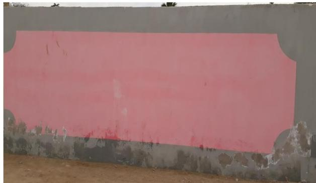
**Figura 16.** Eflorescencia en muro de albañilería. – Fuente: Creación propia.
