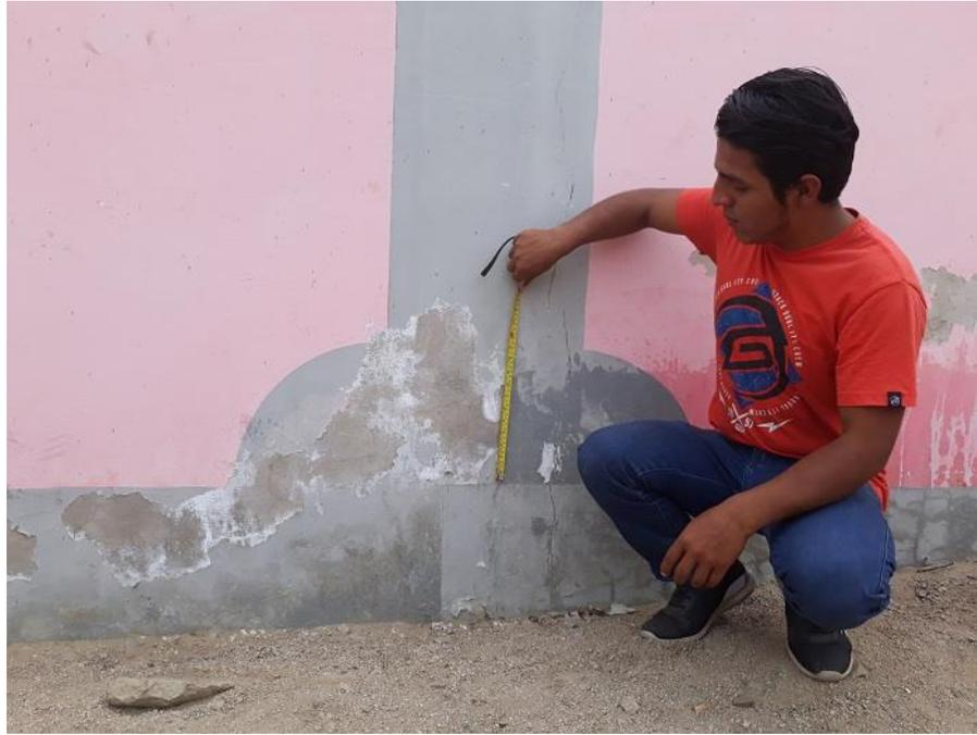
**Figura 99.** Eflorescencia en muro y columna.
