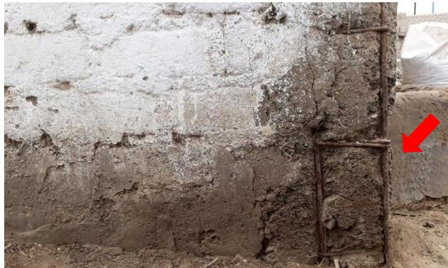
**Figura 17.** Corrosión de la armadura en columna. – Fuente: Creación propia.
