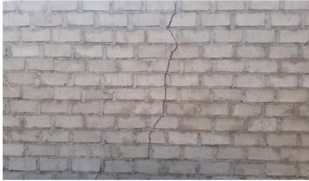
**Figura 12.** Grieta en muro de albañilería.- Creación: Propia.
