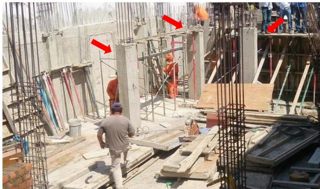
*Figura 3.* Columnas de concreto armado. – Fuente: Creación propia.
