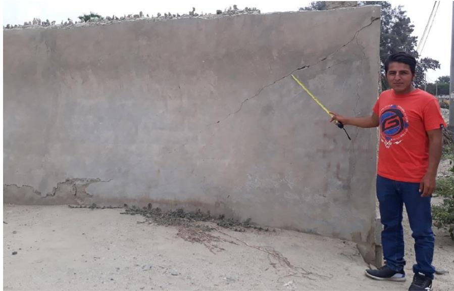
**Figura 101.** Grieta en muro y viga causado por falla por corte.
