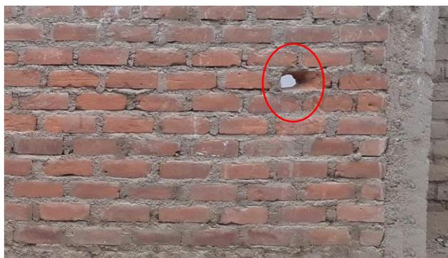
**Figura 14.** Muro afectado por erosión mecánica. –Fuente: Creación propia.
