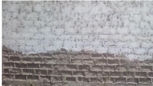
**Figura 15.** Erosión química en muro de albañilería. – Fuente: Creación propia.
