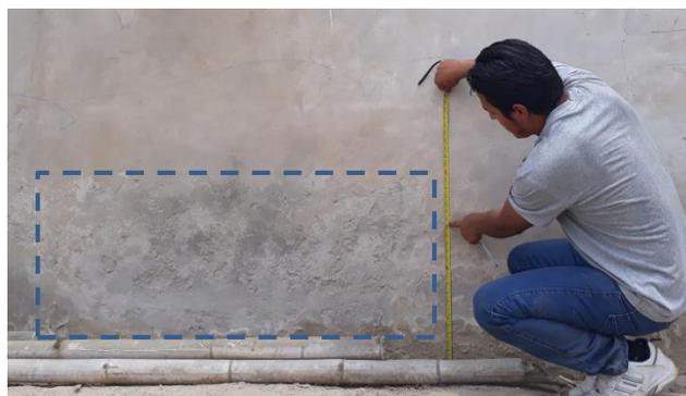
**Figura 10.** Erosión física en muro de albañilería. – Fuente: Creación propia.
