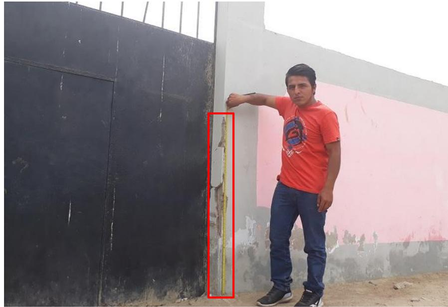
**Figura 100.** Desprendimiento de recubrimiento en columna.
