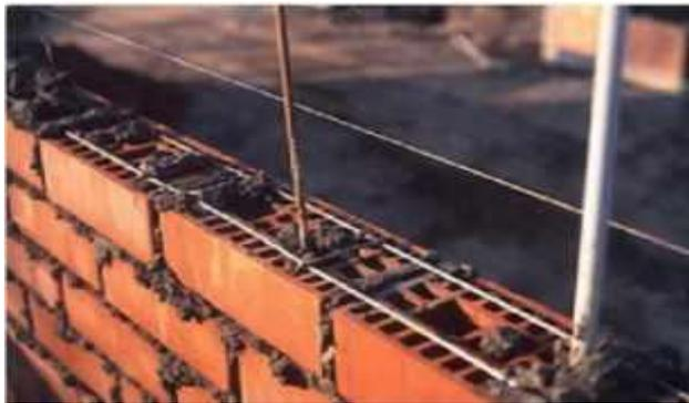
*Figura 8.* Albañilería armada. – Fuente: San Bartolomé.
