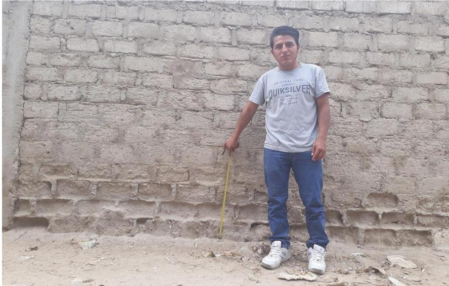
**Figura 103.** Erosión en el muro de albañilería confinada.
