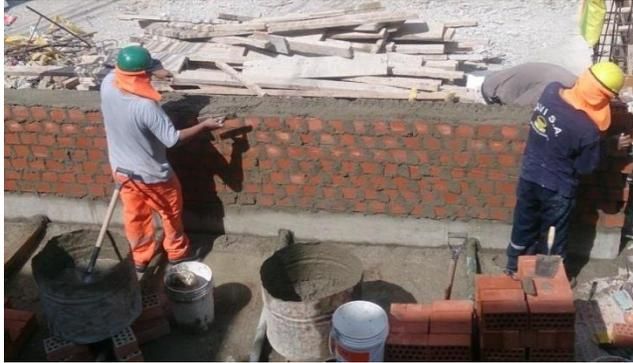
**Figura 5.** Albañiles levantando un muro de albañilería de cabeza.
