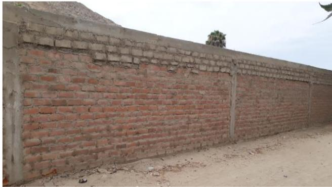
*Figura 7.* Albañilería confinada. – Fuente: Creación propia.
