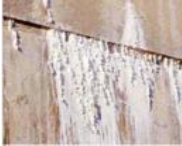
Figura 21: Eflorescencia. Nota. Fuente: Sheila C. (2016)
