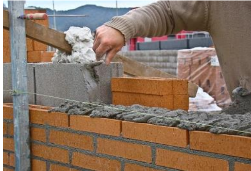
Figura 8: Un ejemplo constructivo con Albañilería. Nota: Fuente: Valderas (2010).
