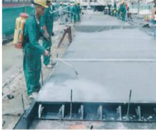
Figura 16: Curado de Concreto. Nota: Fuente: Sika (2009).
