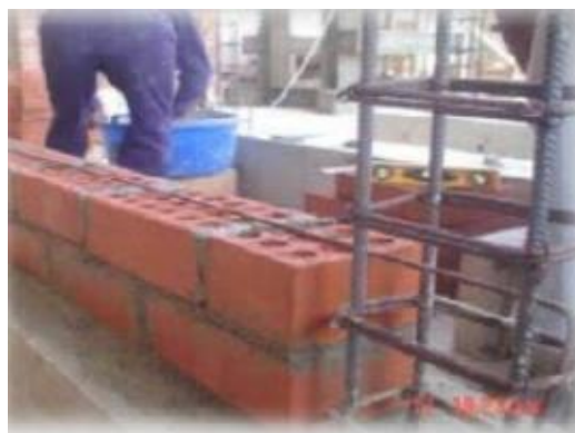
Figura 9: Albañilería Confinada. Nota: Fuente: Kuroiwa H. (2009).
