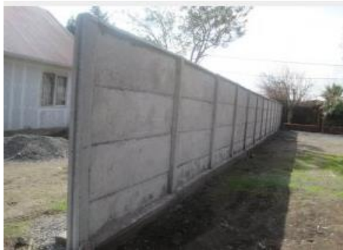
Figura 7: Cerco perimétrico Nota: Fuente: Gemar Vibrados (2011).
