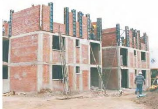
Figura 10: Albañilería Estructural en proceso Constructivo. Nota: Fuente: Kuroiwa H. (2009).
