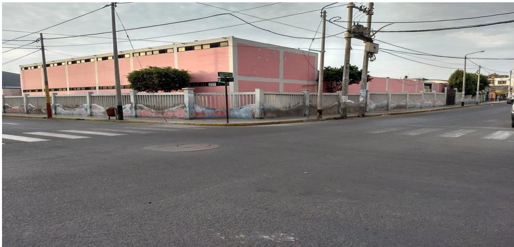
Fotografía N°01: Fachada del cerco de la Institución Educativa Prevocacional, Distrito de Chimbote, Provincia del Santa, Región Áncash.
