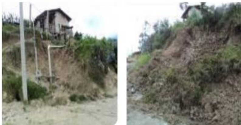
Figura 2: Vivienda emplazada sin criterio técnico y en talud deslizable (Cantón Loja, Parroquia El Valle, Barrio Jipiro Mirador) Nota: Fuente: Guarnizo R. (2015).
