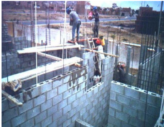
Figura 11: Albañilería Armada en proceso Constructivo. Nota: Fuente: Chumacero I. (2013).
